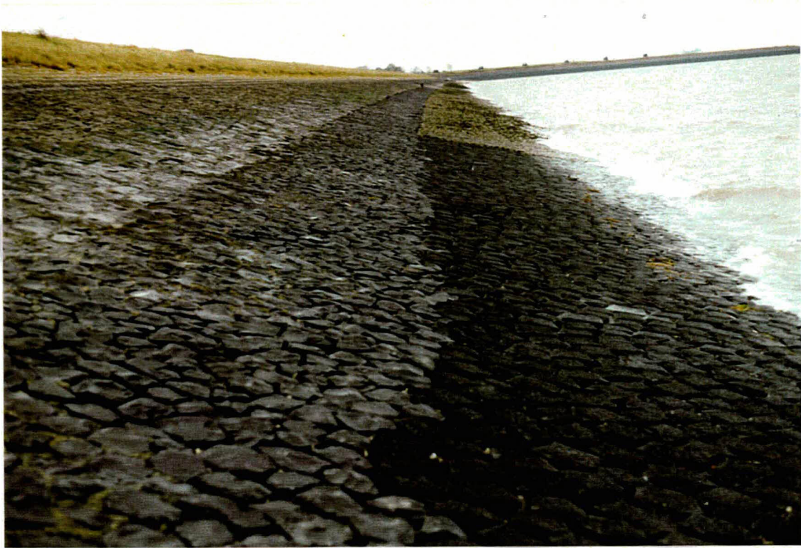
Foto 9 Overzicht van vak 22006: een smalle strook met beton gepenetreerd basalt. Onder de basalt zit basalt, aan de bovenzijde gepenetreerde petit graniet.
