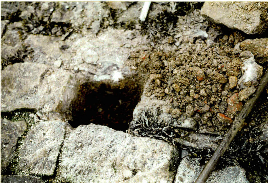
Foto 12 Gat in bekleding van gepenetreerde petit graniet. De stenen staan op een dun puinachtig filter, dat is ingezand.
