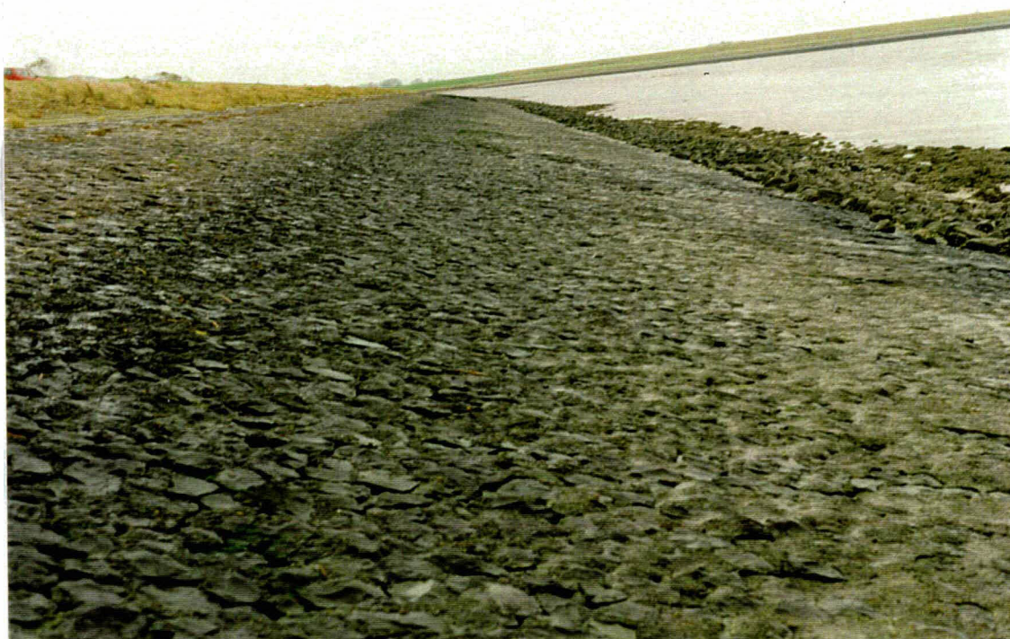
Foto 21 Overzicht van bekleding 19201: met asfalt gepenetreerde basalt. De penetratie is over een groot hoogteverschil aanwezig.
