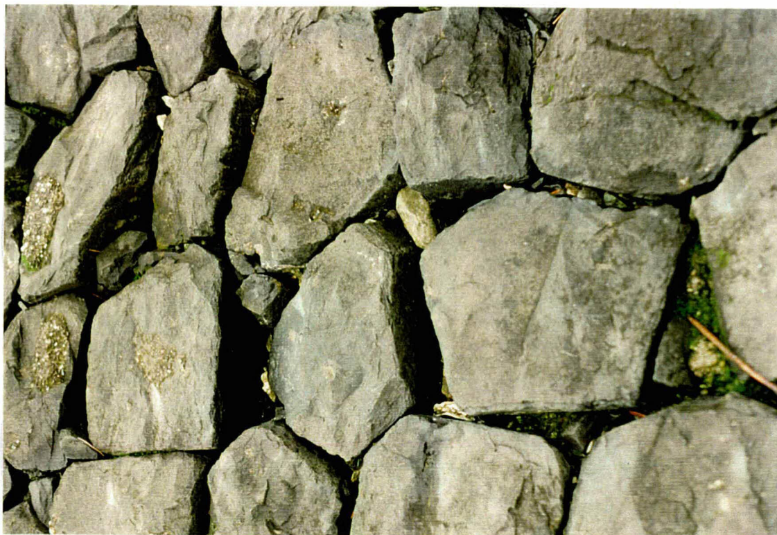
Foto 27 Bekleding 18901: de betonpenetratie is nauwelijks zichtbaar.
