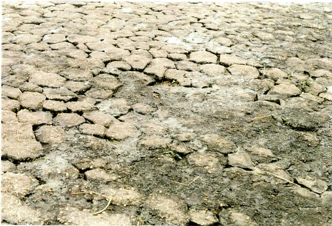
Foto 34 In het talud (bekleding 18604) is bij km 18,85 een deuk aanwezig.
