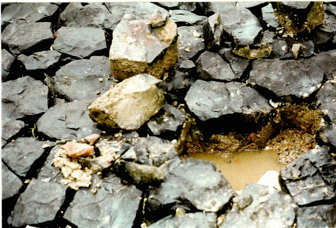
Foto 2 Gat in de basalt bij km 22,5. Er staat al water in het gat voordat er water bij wordt gegoten: de bekleding is waterdicht.
