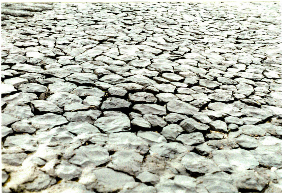
Foto 18 Bekleding 19402 bij km 19,55. Er zit een deuk in het talud. De penetratie lijkt goeddeels verdwenen.
