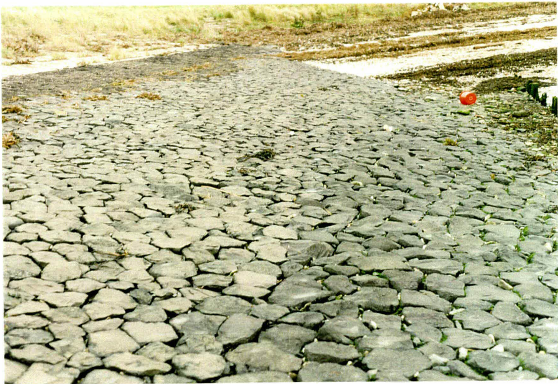
Foto 37 Op de laatste 50 meter van het vak 18604 is de asfaltpenetratie achterwege gelaten. De stenen zijn dicht op elkaar gezet. De spleten zijn dichtgeslibd.
