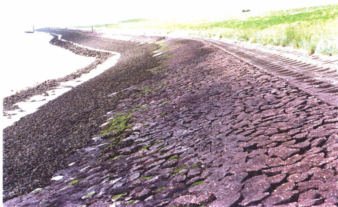
Foto 2 Overzicht van het dijkvak in zuidelijke richting.
