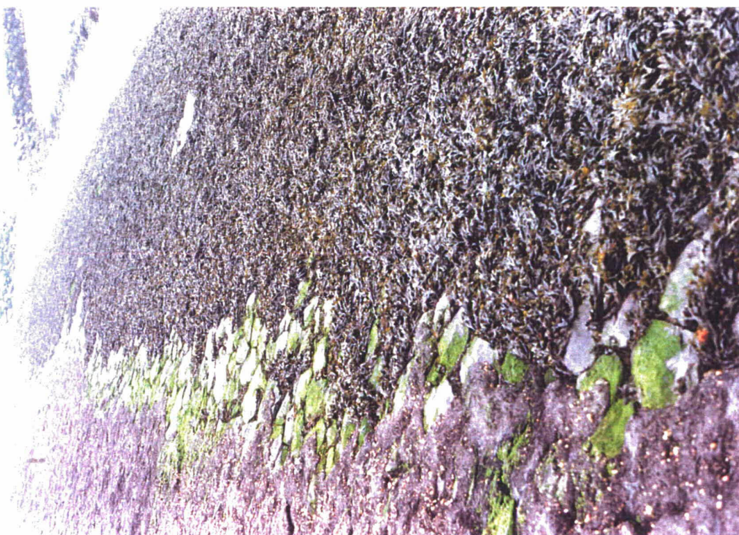
Foto 4 Een strook basalt lijkt hier minder goed gepenetreerd..
