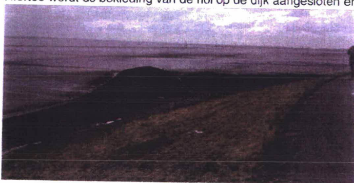
Figuur 1: Huidige situatie verborgen bekleding Baalhoek
