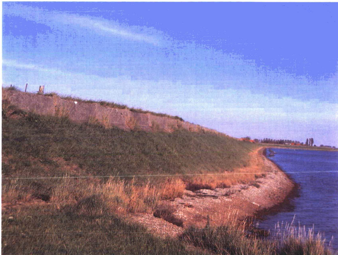
Foto 2.2 De dijk ter hoogte van deelgebied 1 bij hoogwater. Een berm ontbreekt hier.
