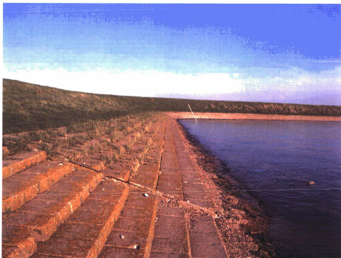
Foto 1.2 Huidige dijkbekleding in deelgebied 5.
