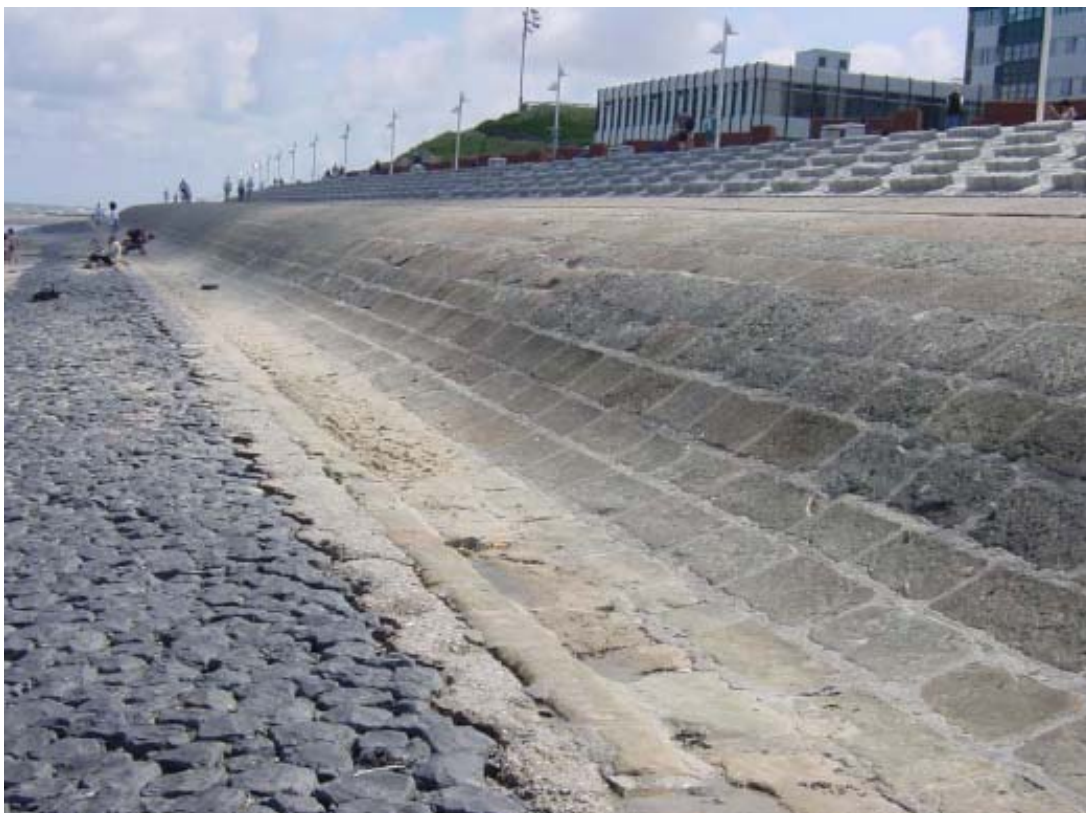
Figuur 4.2: Overzicht talusbekleding Norderney (Noord Duitsland)
