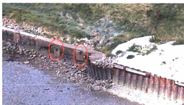
Figuur 2 Constructie zuidzijde voorliggende waterkering, overgang staal naar beton (Bron: PBZ)
