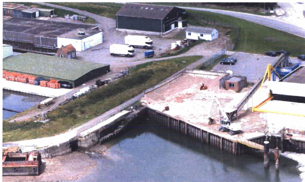
Figuur 5 Oostzijde van voorliggende waterkering
