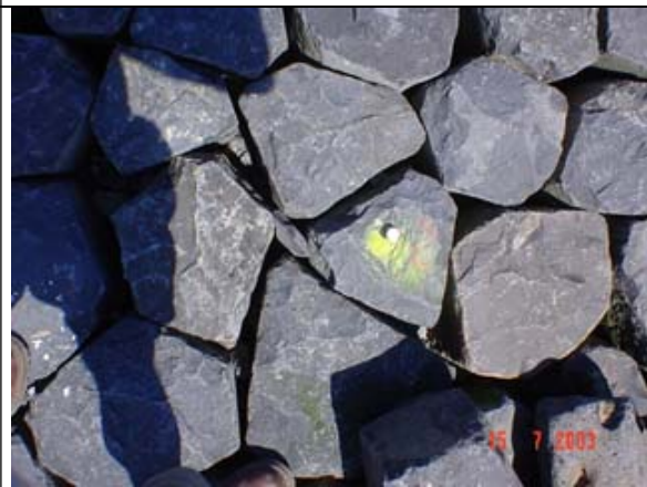
Zuil 4-2 voor inwassen
