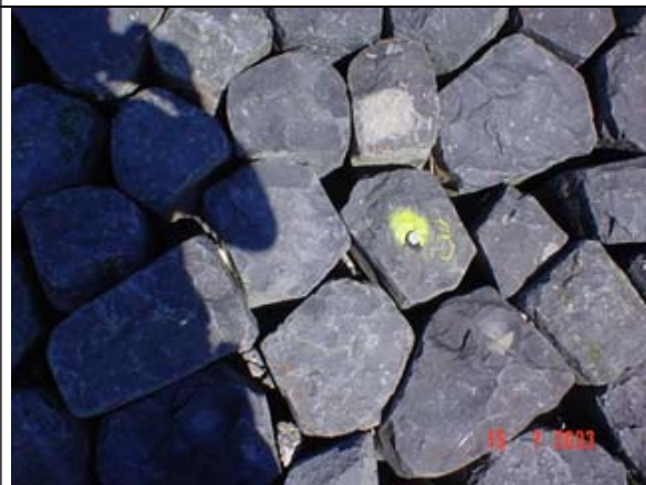
Zuil 3-3 voor inwassen
