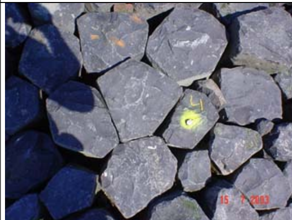
Zuil 3-4 voor inwassen
