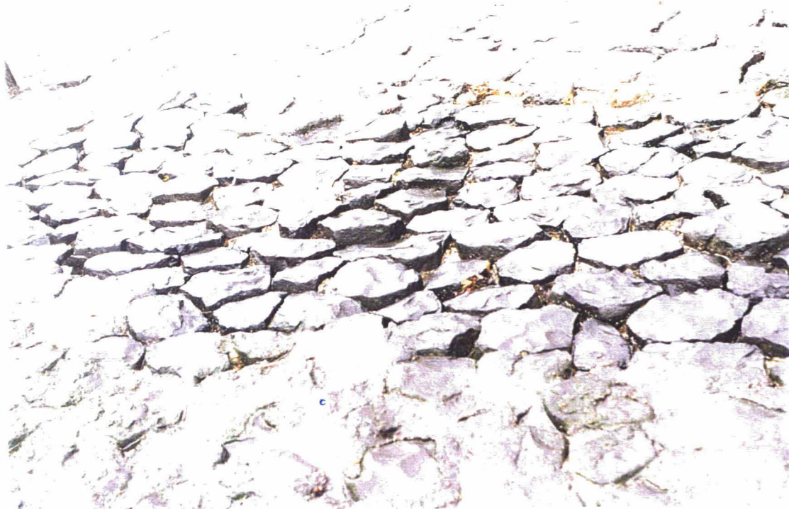
Foto 10 In de bocht bij km 30,1 is de bekleding minder goed. Hier is een gedeelte te zien waar minder asfalt zit en waar de zuilen wat voorover zijn gezakt.
