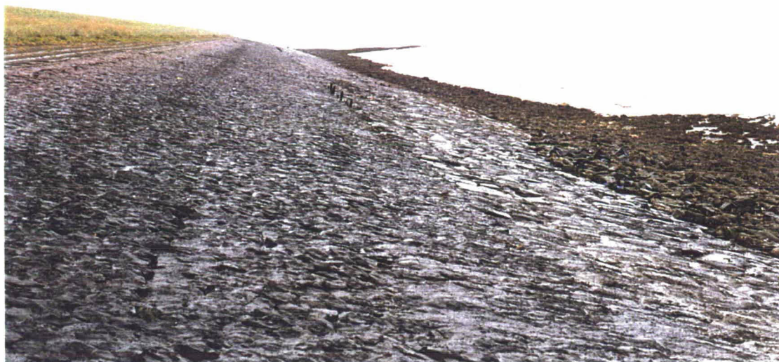
Foto 7 Overzicht van bekleding 29902 in oostelijke richting.
