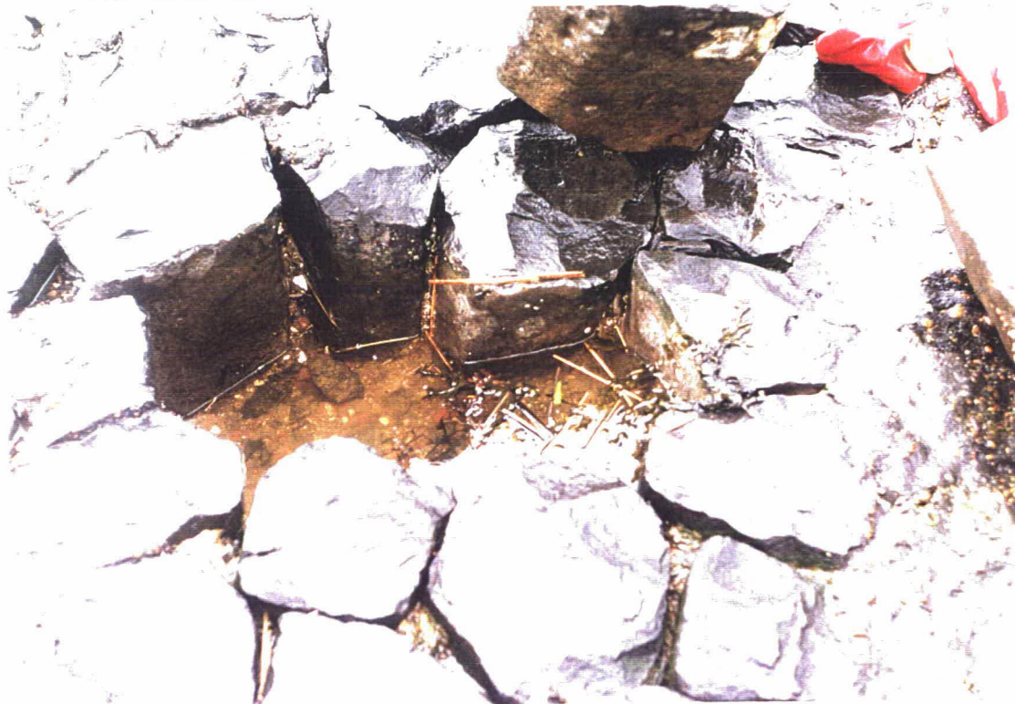
Foto 12 Gat in de basalt bij km 30,1. In het gat staat nog water. Te zien is dat het onderste deel van de spleten tussen de basalt is dichtgeslibd. De penetratie kan dan niet tot onderin doordringen.
