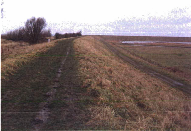
Foto 2.3 De kruin van de dijk tussen dp1900 en dp1905 wordt intensief gebruikt door recreanten (gezien in noord-oostelijke richting). Een berm aan de buitenzijde(links) ontbreekt vanwege het aanwezige duinterrein. In de toekomstige situatie is de kruin verhard met een onderhoudspad van asfaltbeton.
