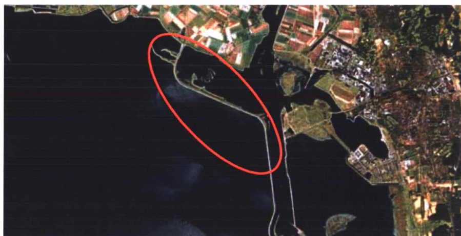
Figuur 1.2: Luchtfoto van het dijktraject Oesterdam-Noord (bron: google.earth.nl).
