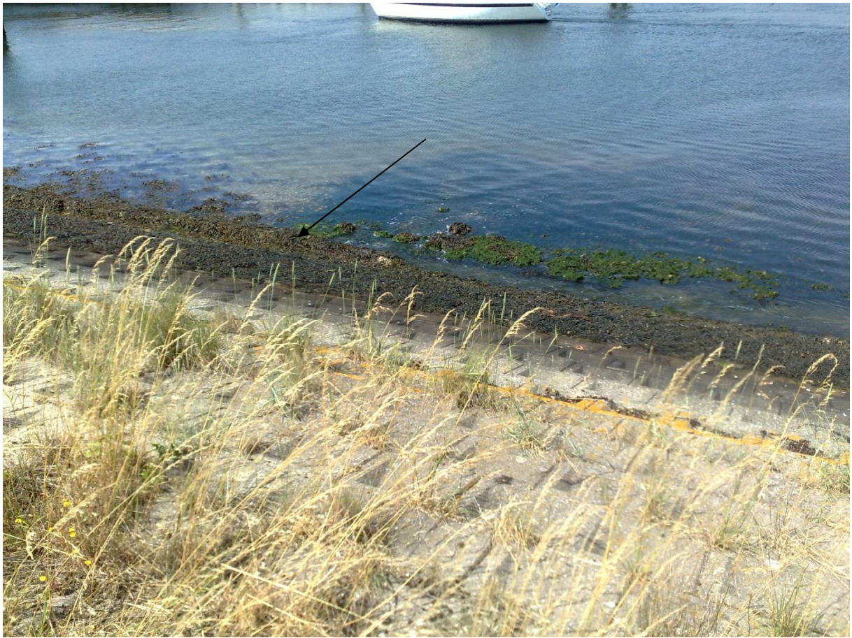
Uitstroombuis zagerkwekerij Topsy Baits. De buis is bedekt met wier. De uitstroomopening bevindt zich ter hoogte van de pijl.
