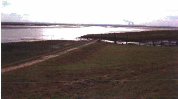
Figuur 23: Huidige situatie overgang havendam – kleidijk
