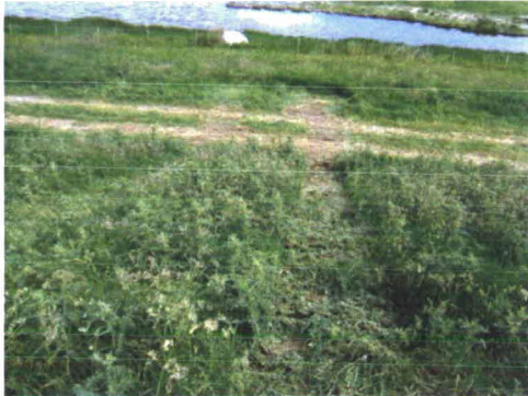
Afbeelding 3: Binnentalud ter hoogte van Ouwerkerkse inlaag
