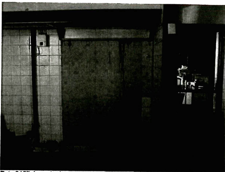
Foto 2157: bron 4, plaat tegen muur in keuken, paviljoen
