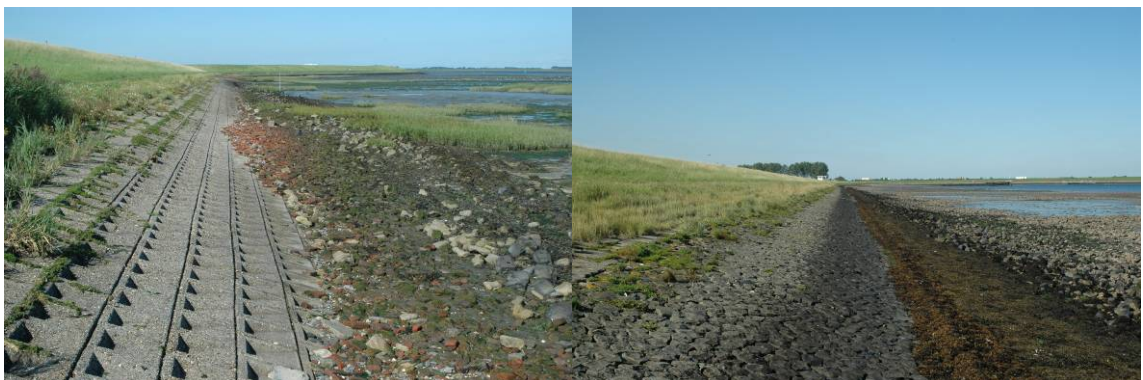
Foto 1.1: Dijktraject Zandkreekdijk - Wilhelminapolder West.
