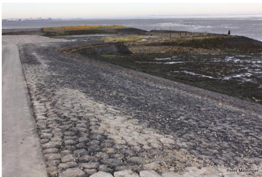
Basalt rond landbouwhaventje; ook hier nog wat veel steenslag.
