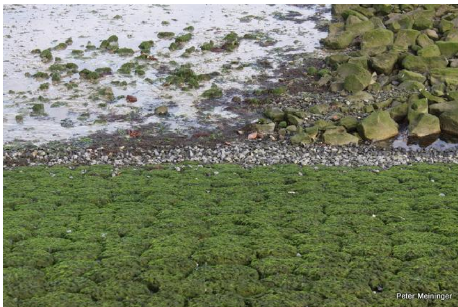
Dijktraject Sint Pieterspolder. Ophoping van steenslag aan dijkvoet.
