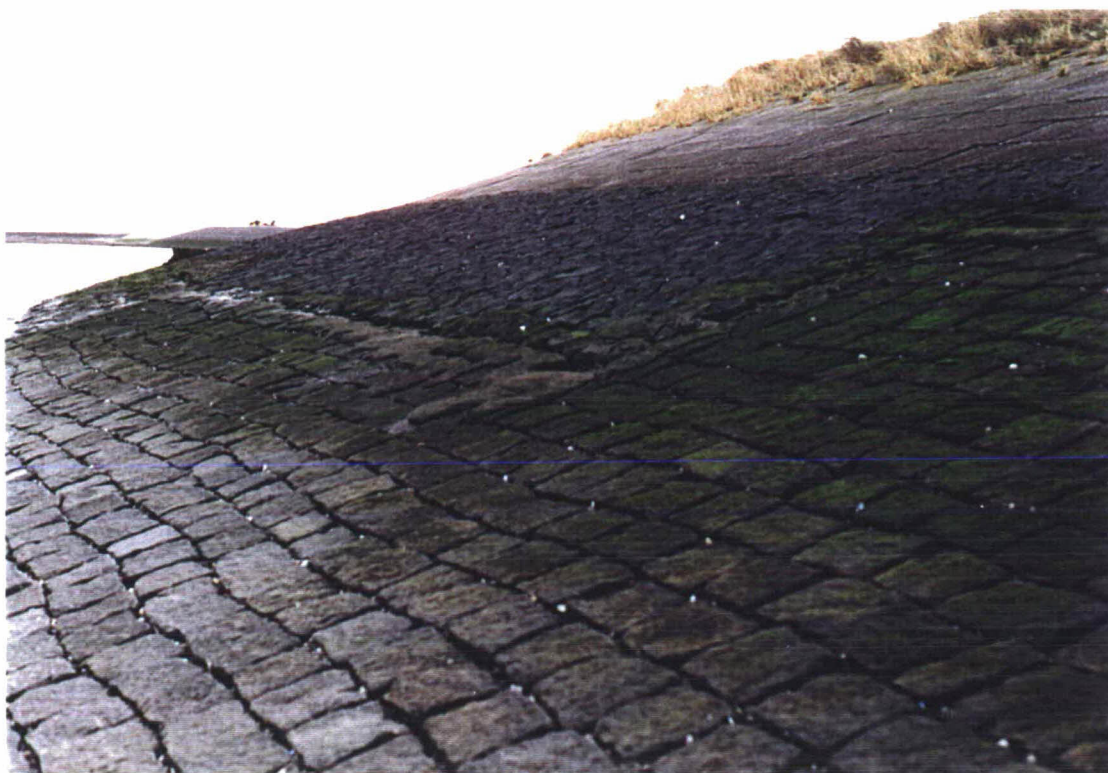
Foto 5: De hoogte waarover de granietblokken aanwezig zijn varieert. (foto bij dp 260+30 m in oostelijke richting)
