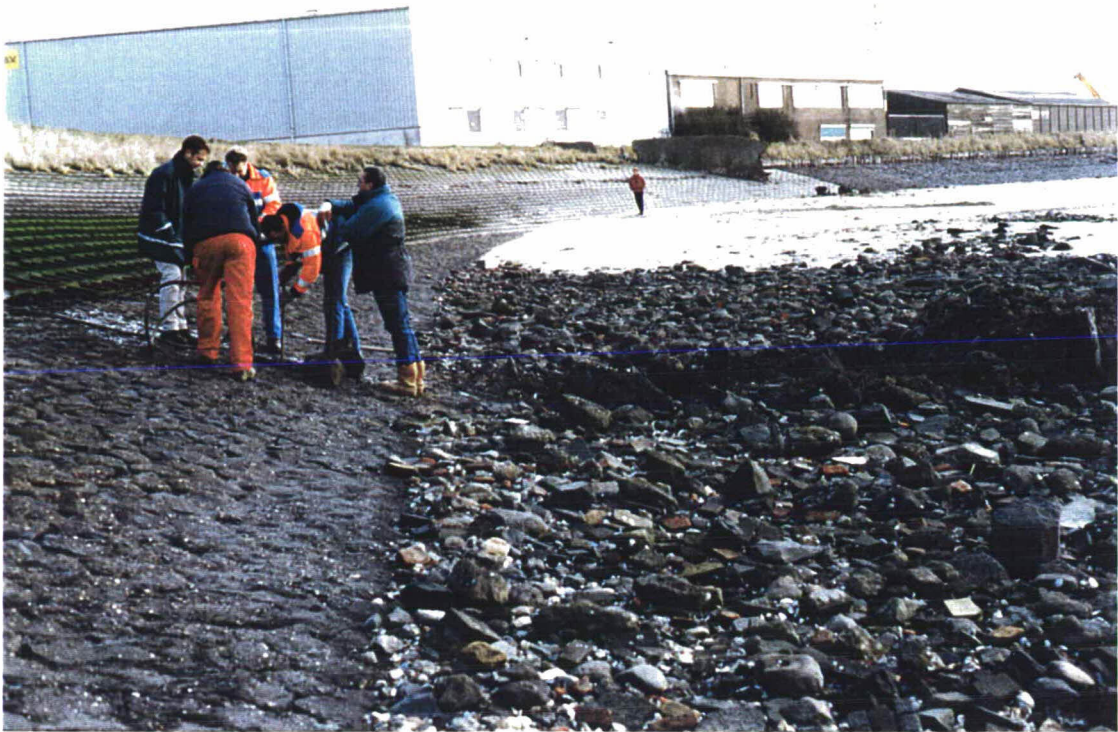
Foto 9 Hoogteligging van de gaten
