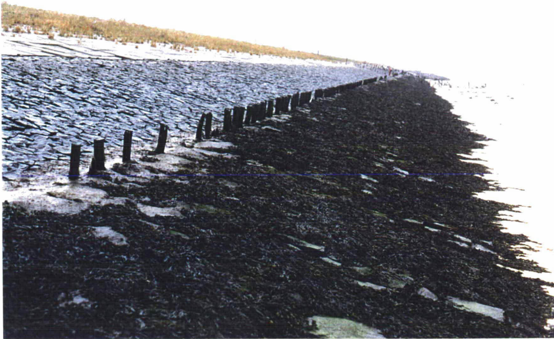
Foto 13 Foto genomen bij dp 272 in westelijke richting. De Doornikse steen is hier over grotere hoogte aanwezig. Er is een sterke begroeiing met blaaswier.
