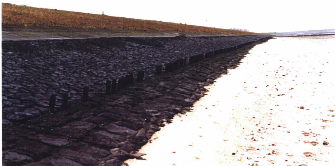
Foto 10 Overzicht van de locatie ten westen van de veerhaven. Foto genomen bij dp 269 in westelijke richting. Getoetst wordt de smalle strook Doornikse steen onderaan het talud.
