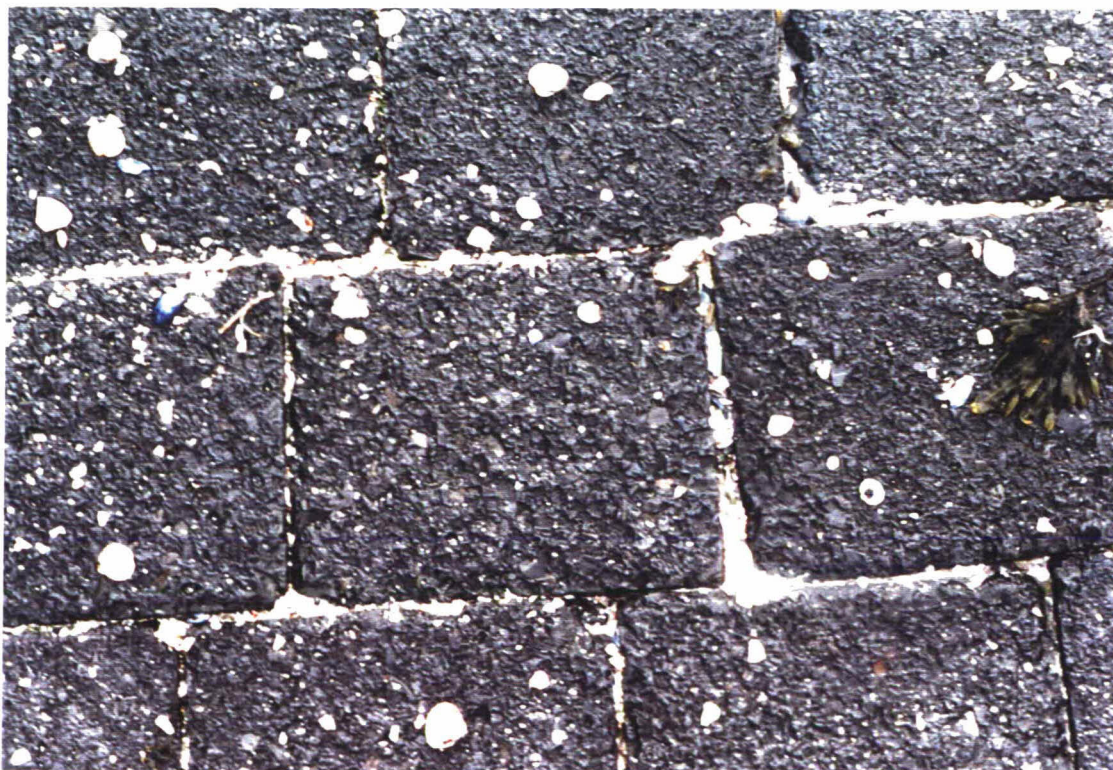
Foto 6 De koperslablokken laag op het talud zijn kleiner van formaat. De spleten zijn smal en volledig gevuld met schelpgruis.
