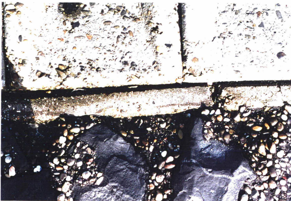
Foto 4: Overgangsconstructie van gepenetreerde basalt naar Haringmanblokken
