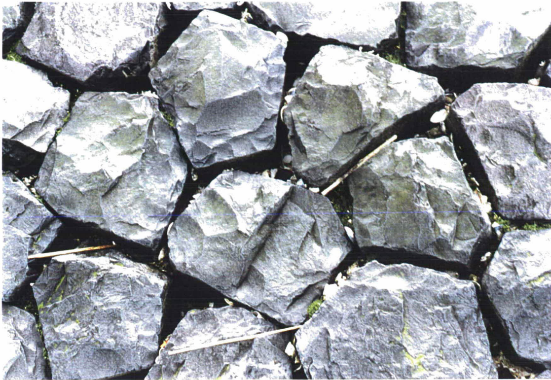
Foto 11 De basalt bij dp 92 hoog op het talud is vrij open, de spleten tussen de zuilen zijn half gevuld met schelpen.
