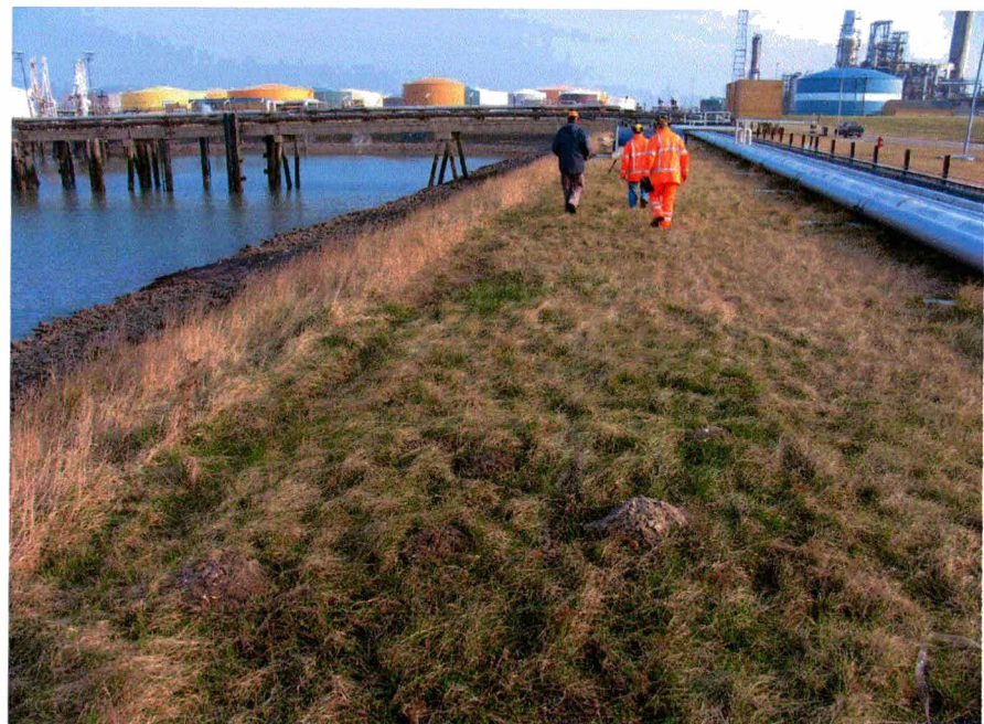
Berm met leidingenstraat
