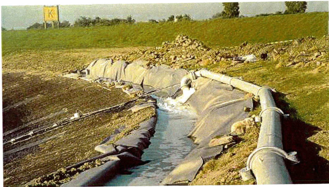
Infiltratiesloot met toevoer van water
