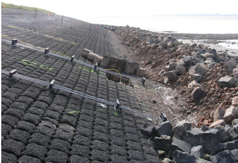
Figuur 4.2 Proeflocatie Willemspolder, merk op dat de bestorting op de teen op de voorgrond nog aanwezig is, maar op de proeflocatie is deze voor de teen gedeponeed.
