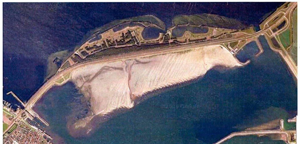
Figuur 1.2. Luchtfoto van het dijktraject Grevelingendam (bron: google.earth.nl)
