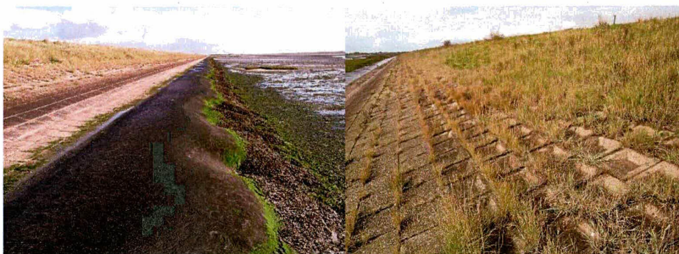
Foto 2.1. De ingegoten kreukelberm en haringmanblokken (ondertafel) en vlakke betonblokken (boventafel) tussen dp 431 tot en met 473.
