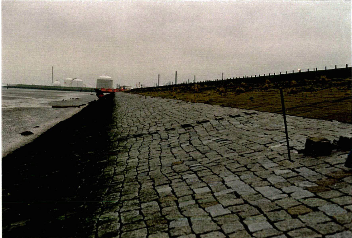
Foto 1 Overzicht van de lokatie vanaf dp 69 in oostelijke richting
