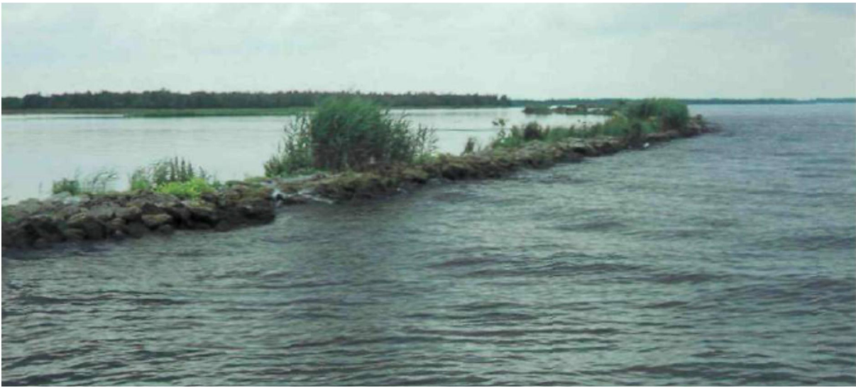
Figuur A.5b: Vooroeververdediging tegen golfwerking (RWS-RIZA 1998).
