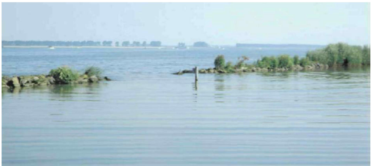
Figuur A.5a: Vooroeververdediging met doorlaatopening, RWS-RIZA, 1998.
