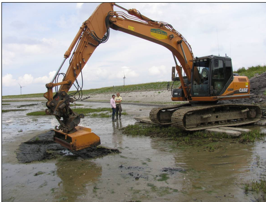
Foto 2. Rooiwerkzaamheden, donorlocatie Krabbenkreek Noord (Abraham Wissepolder), 11 juni
