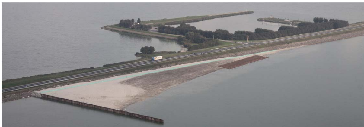
De proefsectie aan de zuidkant van de Houtribdijk, vlak na aanleg in oktober 2014. Aan noordzijde ligt de Trintelhaven
