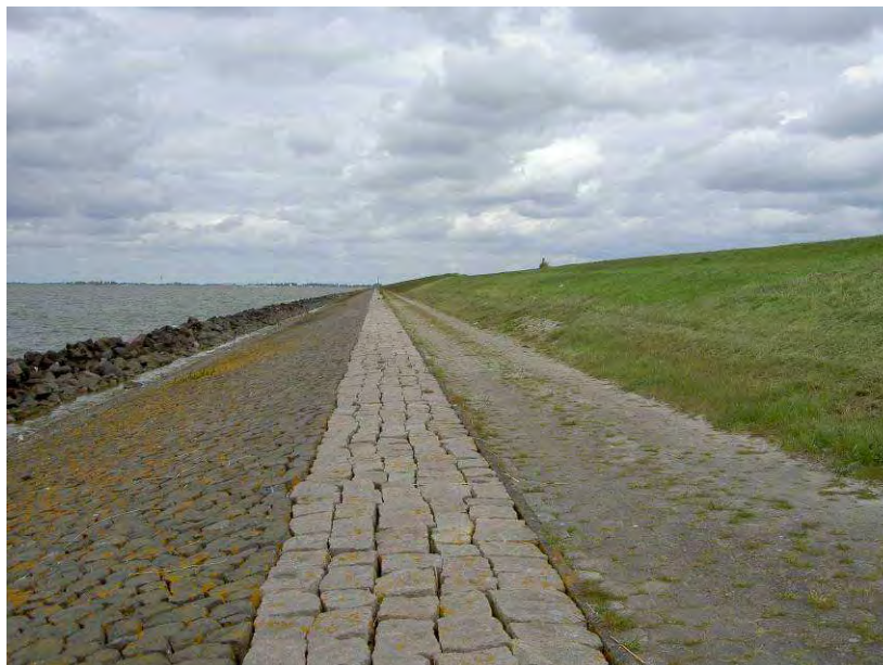
Figuur 4.16 Voorbeeld niet-natuurlijke oeververdediging Noordermeerdijk. (Foto: RPS)
