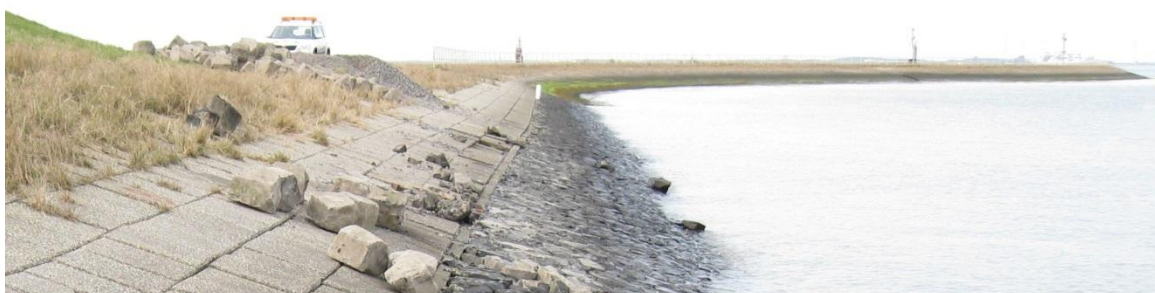
Figuur 2.1 Oostelijke havendam (op de voorgrond: aansluiting op de waterkering)
