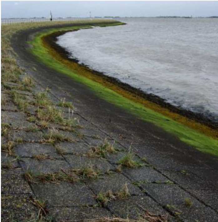
Figuur 4.5 Oostelijke havendam (foto Panoramio)
