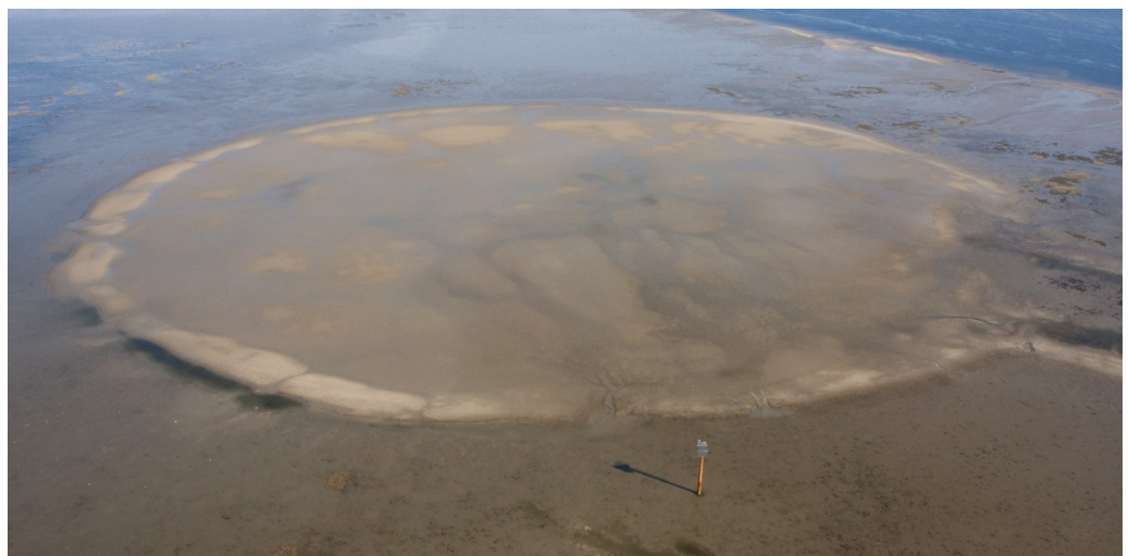
Figuur 1: Proefsuppletie Galgeplaat (uitgevoerd in 2008). © Edwin Parea, 2009
