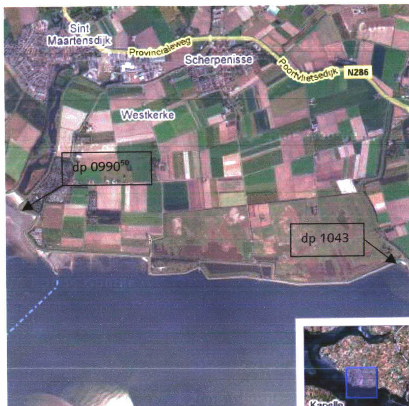
Figuur 2: Luchtfoto traject Geertruidapolder, Scherpenissepolder dp 0990 50 – dp 1043 (bron: www.maps.google.nl )
