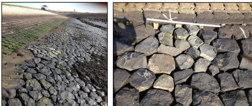
Foto 2a en b: gerepareerde basalt
