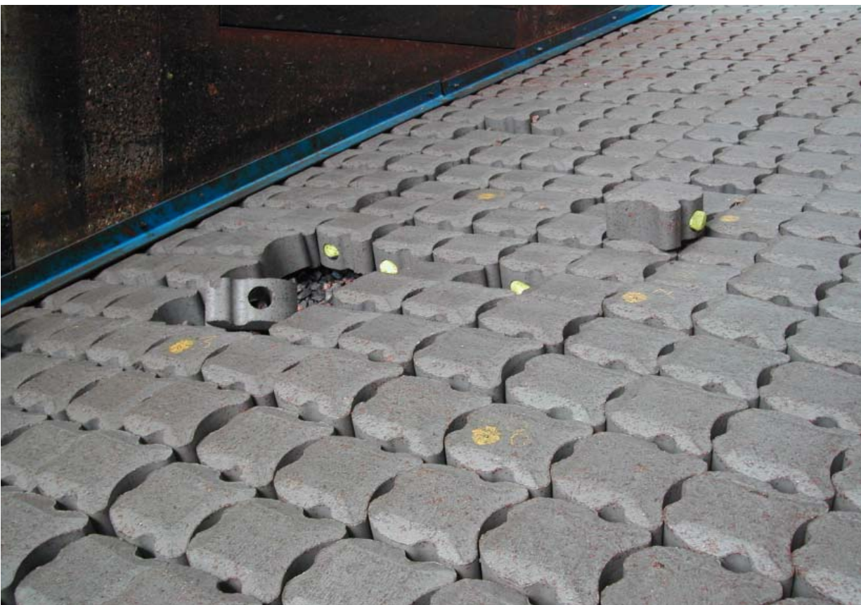
Schade na proef 26 (1)
