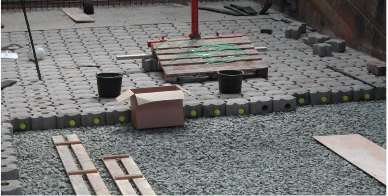
Bouw van de steenzetting met Hydroblocks, waarin een gele cylinder van polystyreen is aangebracht
