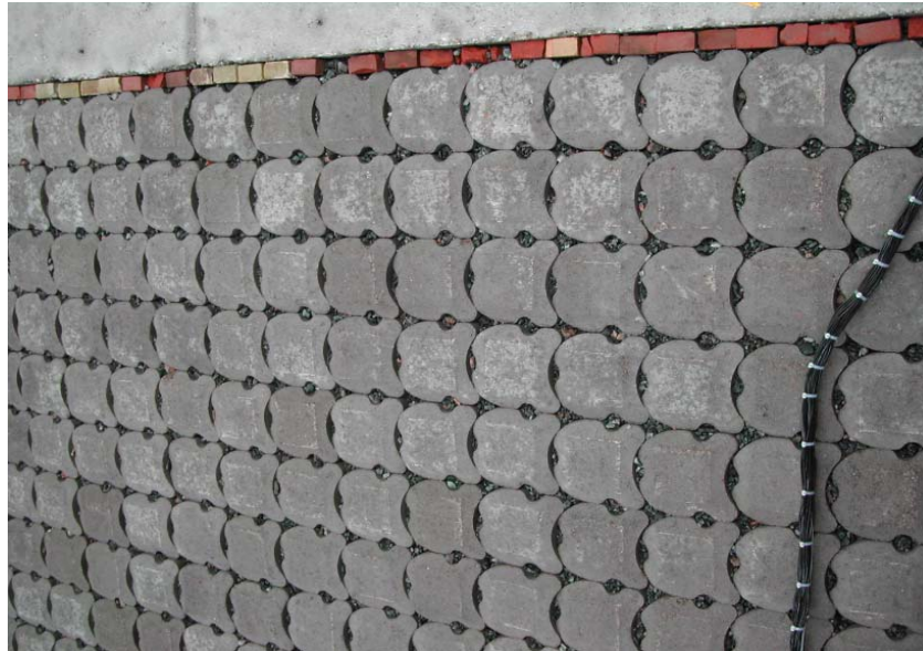
Afwerking langs bovenrand
