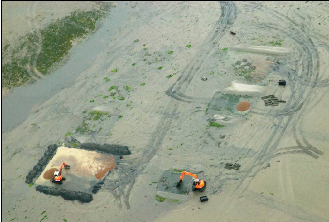
Foto 4: Luchtfoto van werkzaamheden op de Dortsman Noord
