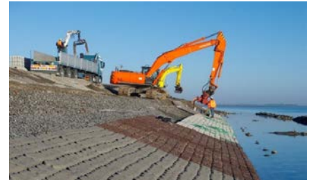
Plaatsing van de Hydroblocks op de dijk bij Sint-Annaland. (mei 2015)
