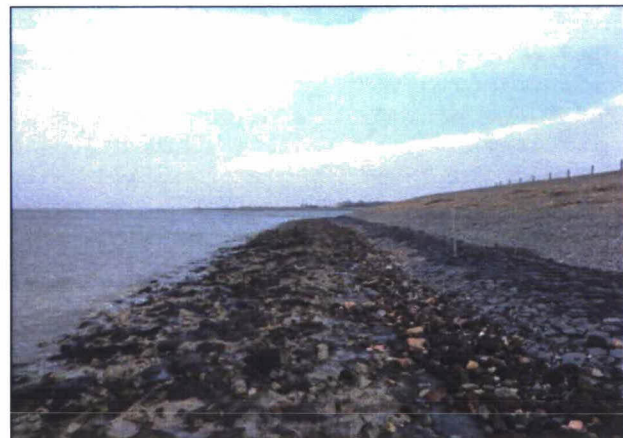
Foto 5 en 6: dp 175-181 - breuksteen overlaagd met breuksteen 10/60 kg volledig geopenetreerd met gietasfalt en afgestrooid met lavasteen 60/120 mm
