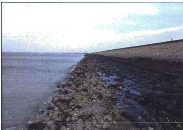
Foto 5 en 6: dp 175-181 - breuksteen overlaagd met breuksteen 10/60 kg volledig geopenetreerd met gietasfalt en afgestrooid met lavasteen 60/120 mm
