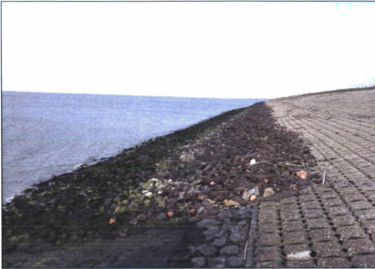
Foto 1 en 2: dp 168 - 169 - Petit graniet is overlaagd met breuksteen 10/60 kg volledig geopenetreerd met gietasfalt en afgestrooid met lavasteen 60/120 mm
