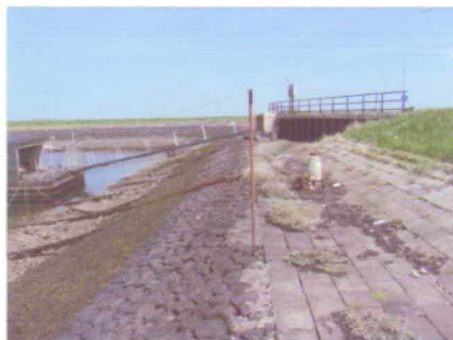
Figuur 3: Glooiing in de veerhaven Sluis
