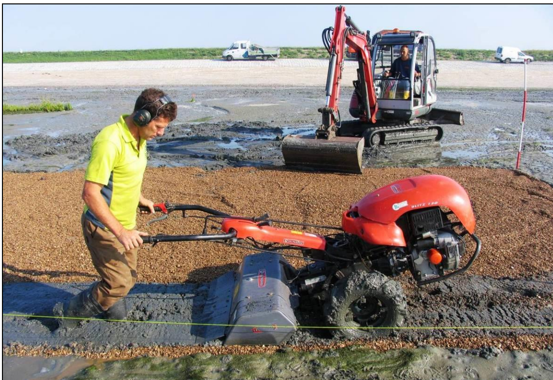
Foto 3 Aanbrengen schelpenlaag langs zeegrasveld op Dortsman Noord
