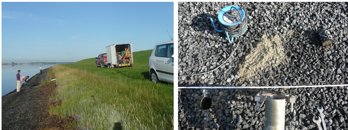
Figuur 3: Boring op locatie bij dijkspaal 690. In dit geval is er geboord door 16 cm fixstone bekleding. Daaronder werd droog zand aangetroffen.
