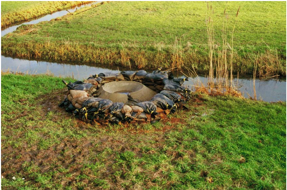
2.13e: Zandmeevoerende wel op maaiveld (opgekist, niet meer actief), langs de Waal nabij Hesselt. [RWS-DWW 916_19; www.BeeldbankVenW.nl , Rijkswaterstaat: RWS-DWW_310149]
