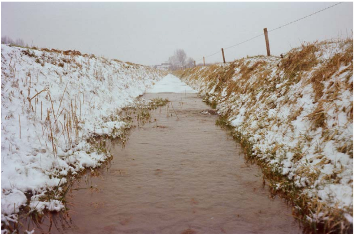
2.5: Stroming zichtbaar in de sloot aan de binnenteen van de Waaldijk te Herwijnen, tijdens vorstperiode. Plaatselijk is de sloot niet dichtgevroren. [RWS-DWW 199/24]
