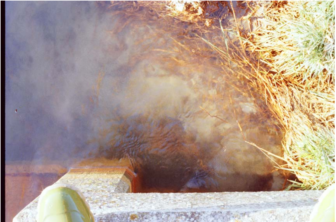
4.12: Zandmeevoerende wel bij de aansluiting van het achterloopsheidsscherm van een betonnen sluis, bij de uitstroomopening. De keermiddelen van de sluis bevinden zich in gesloten stand. [DWW 191/17a].
