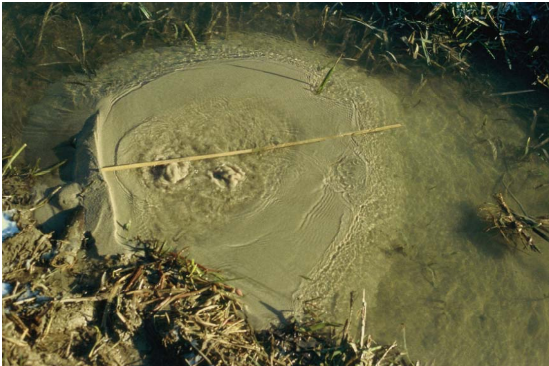
2.14b: Zandmeevoerende wel in begin van kopsloot bij Maasdijk/Nederrijn nabij Kersteren tijdens hoogwater 1982 [RWS-DWW 204_32a; www.BeeldbankVenW.nl , Rijkswaterstaat: RWS-DWW_310017]
