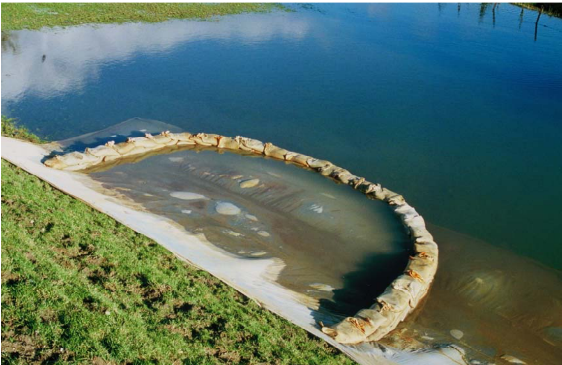
2.13d: Opgekiste zandmeevoerende wel aan binnenteen. Kwel wordt bestreden met plastic folie. Lathumse dijk/IJssel. [RWS-DWW 896_02; www.BeeldbankVenW.nl , Rijkswaterstaat: RWS-DWW_310114]
