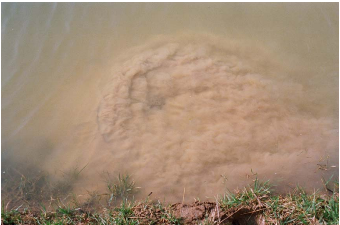
2.12b Zandmeevoerende wel in kopsloot nabij gemaal Kandia (Pannerdens kanaal / Nederrijn). Bij de beoordeling van het 'algemene' dwarsprofielen dienen deze kopsloten nadrukkelijk mee te worden genomen. [RWS-DWW 469/11a]
