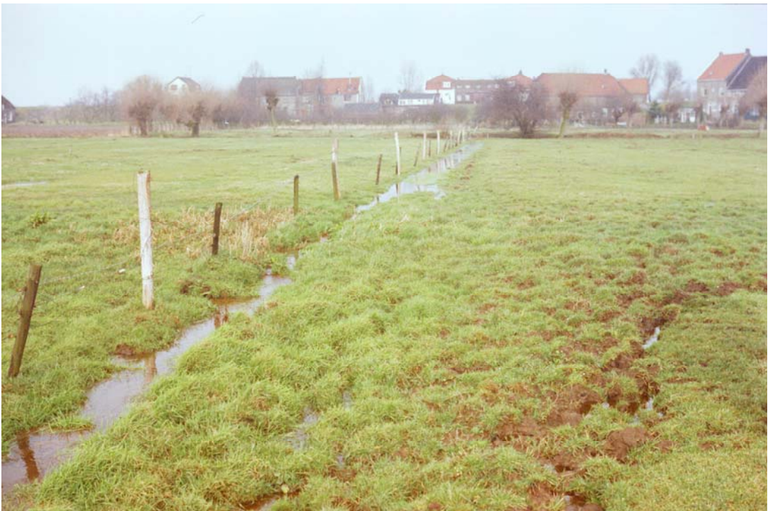
2.3a: Lokaal omhoog komen en verdrassing van het achterland achter de havendijk te Woudrichem, ter plaatse van een kopsloot. [RWS-DWW 128/4]
