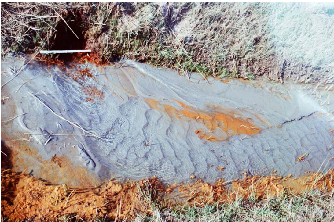
2.11: Zandmeevoerende wel in slootkant hmp 348 Waalbandijk Noord, na een hoge buitenwaterstand. Het zand is hier direct afgevoerd in de sloot. [RWS-DWW 132/4a]
