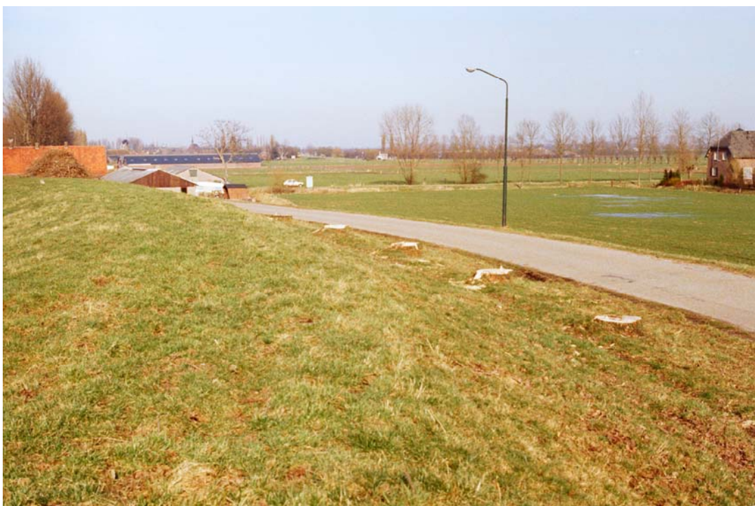
1.4b: Afgezaagde bomen op het binnentalud van de Megensedijk (Maasdijk). Zowel het verwijderen van de stronk als het laten zitten is een risico. Mogelijk leidt dit in de toekomst tot ongewenste gangvorming t.p.v. de oorspronkelijke wortels. [RWS-DWW 323/18a]
