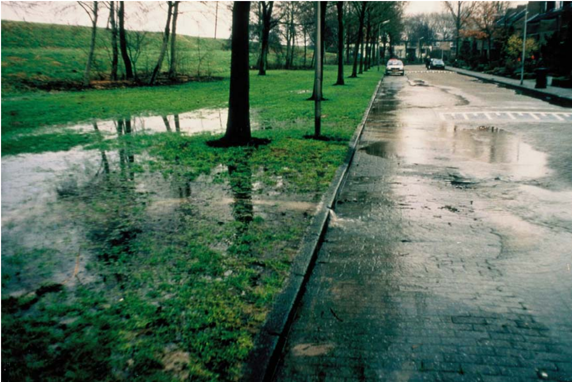
2.2b: Kwel binnendijks rivierdijk tijdens hoogwater 1993. [DWW 854a_02] [www.BeeldbankVenW.nl, Rijkswaterstaat: RWS-DWW_310094]
