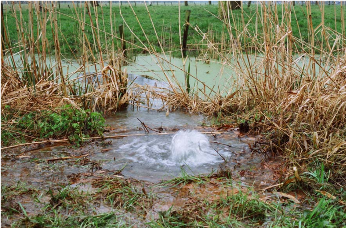
2.8: Schoon water spuit achter de dijk boven het maaiveld uit. Opvallend is dat dit vlak voor een sloot optreedt. Mogelijk is dit het gevolg van graverijen of een niet afgedicht boorgat. [RWS-DWW 470/20]
