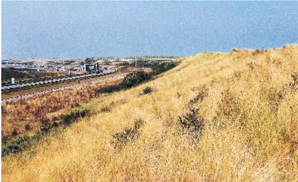
Figuur 3-16: Zandsuppletie met helm beplant op het binnentalud van de Veersedam – 2000 (foto NPC)
