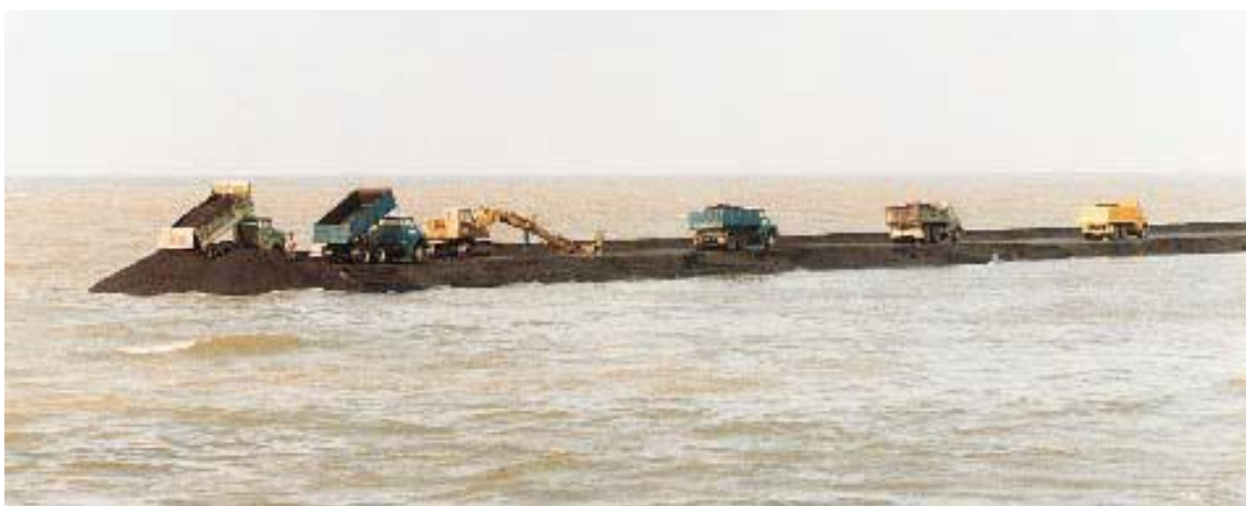
Figuur 8-25: Uitrijden van zandasfalt voor de bouw van een dam - Zeebrugge in België (foto Bitumarin)
