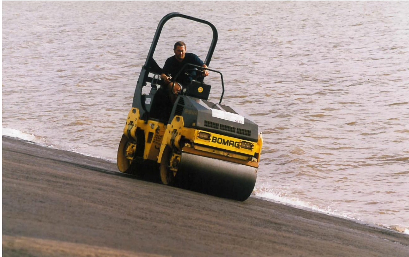
Figuur 8-15: Tandem-, trilwals voor de naverdichting – Paviljoenpolder (foto Bitumarin)
