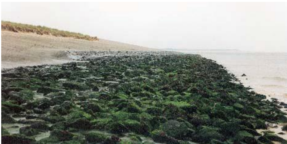
Figuur 3-1: Bekleding van gepenetreerde breuksteen (onder) en waterbouwafaltbeton (boven) om erosie van het zandlichaam te voorkomen - Veersedam (foto NPC)
