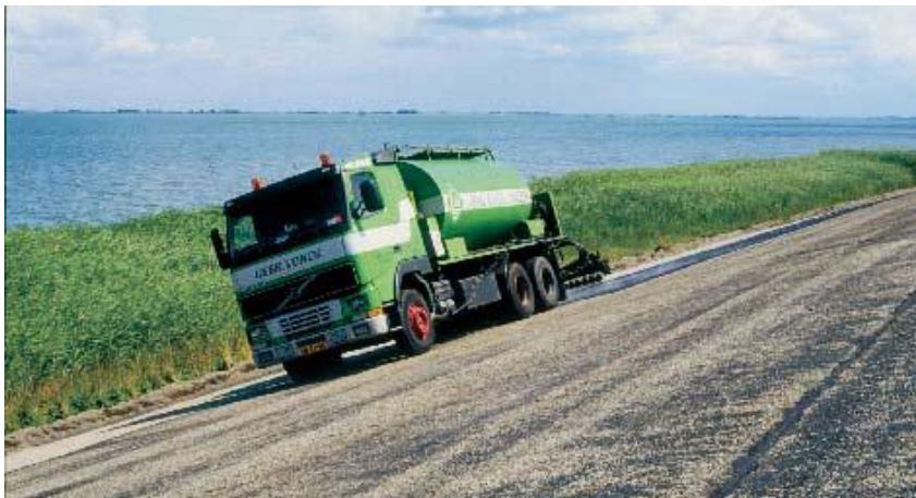
Figuur 8-29: Machinaal sproeien van bindmiddel voor het aanbrengen van een oppervlakbehandeling (foto ESHA)
