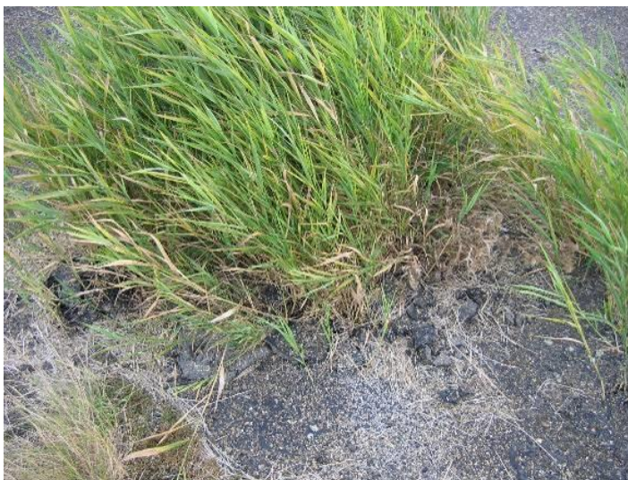
Figuur 9-14: Doorgroeiing met riet
