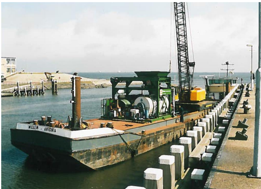
Figuur 8-7: Drijvende opmenginstallatie voor verwerking van asfalt onder water – Pontfuike TESO, Den Helder en Texel (foto Ooms Construction)
