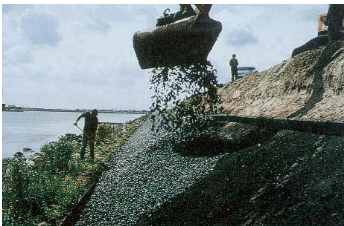
Figuur 13-6: Filter van zandasfalt waarop open steenasfalt wordt aangebracht – Hartelkanaal (foto Bitumarin)
