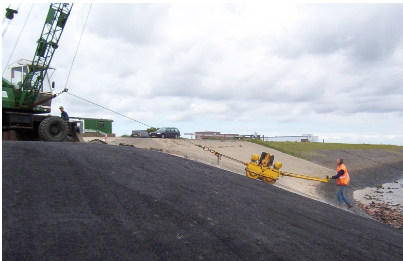
Figuur 8-14: Verdichten van waterbouwasfaltbeton met afgelieerde tandem trilwals – Veerhaven Texel (foto Ooms Construction)
