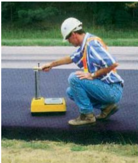
Figuur 10-2: Nucleaire dichtheidsmeter op een asfaltverharding (foto NPC)
