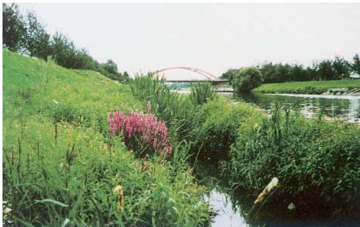
Figuur 13-5: Begroeide vooroeververdediging - Zeekanaal Brussel-Schelde in België (foto Bitumarin)
