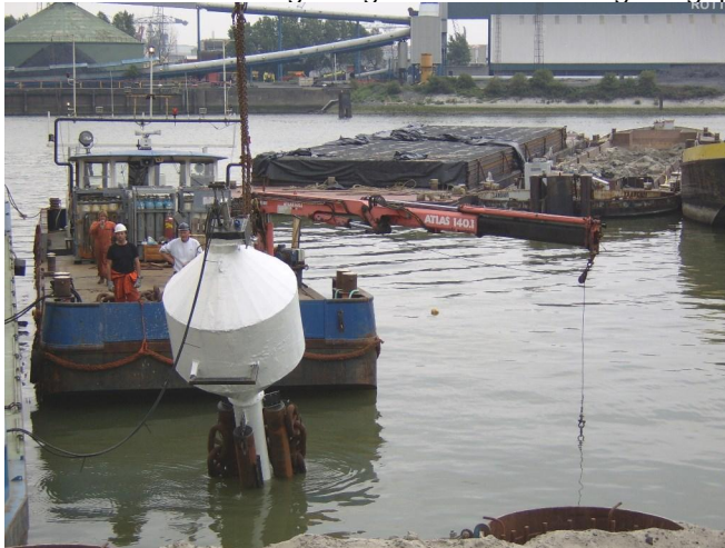
Figuur 8-25: Gesloten stortkoker voor aangieten van naden onder water – Vulcaanhaven (foto Hydraphalt)
