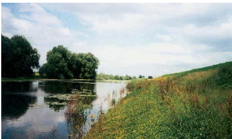
Figuur 3-3: Begroeide bekleding van open steenasfalt aan de Waal bij Dodewaard (foto Oranjewoud)
