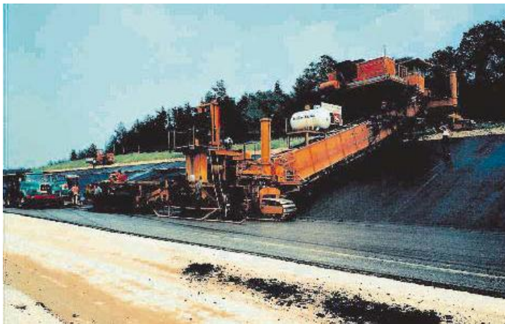
Figuur 8-10: Taludmachine (totaalprofiel) (foto [39])
