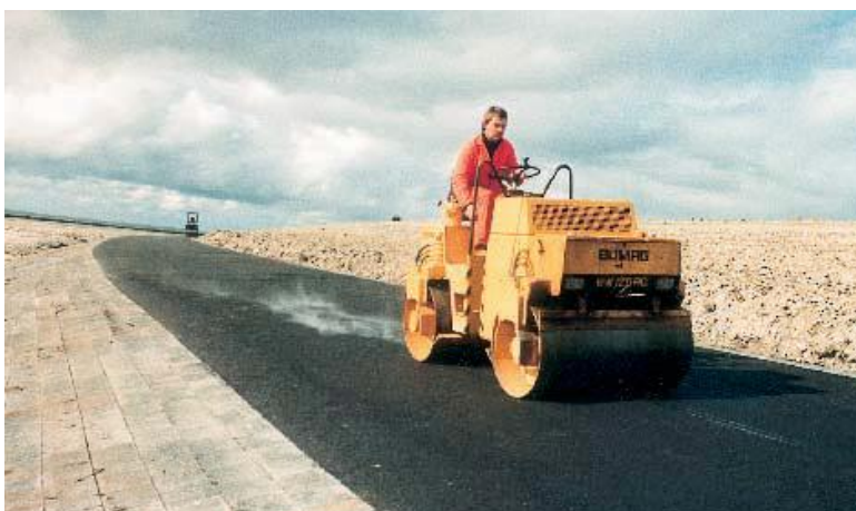
Figuur 4-26: Aanleg onderhoudsweg op berm - Ameland - 1987
