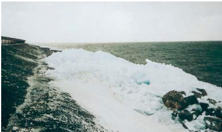
Figuur 3-10: Bekleding van open steenasfalt belast door kruiend ijs – Houtribdijk (foto Bitumarin)
