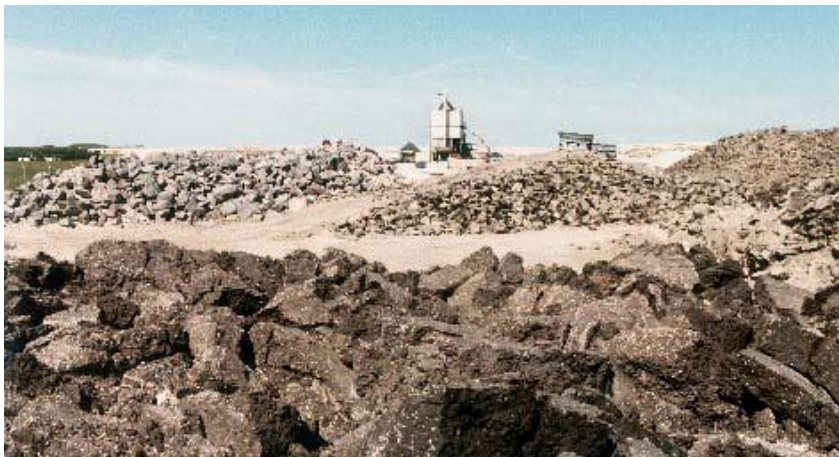
Figuur 8-31: Depot asfalttschollen voor hergebruik in bekleding van waterbouwasfaltbeton - Onrustpolder – 1985
