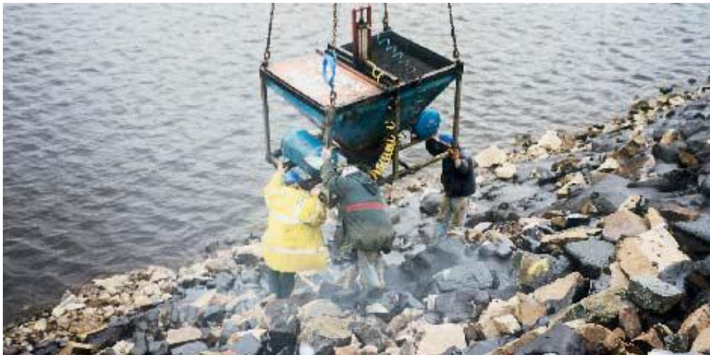
Figuur 8-18: Patroonpenetratie van gietasfalt met een kubel - Meggetdam in Schotland (foto Bitumarin)
