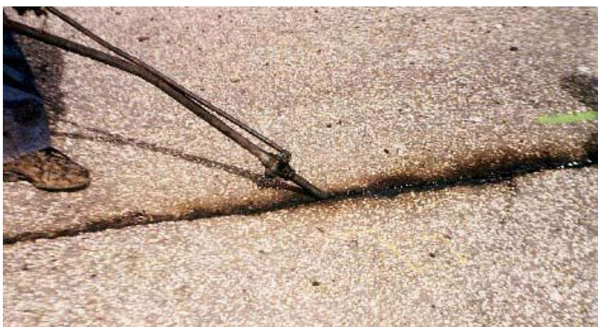
Figuur 10-9: Vullen van scheur met bindmiddel - Roggeplaat – 1986
