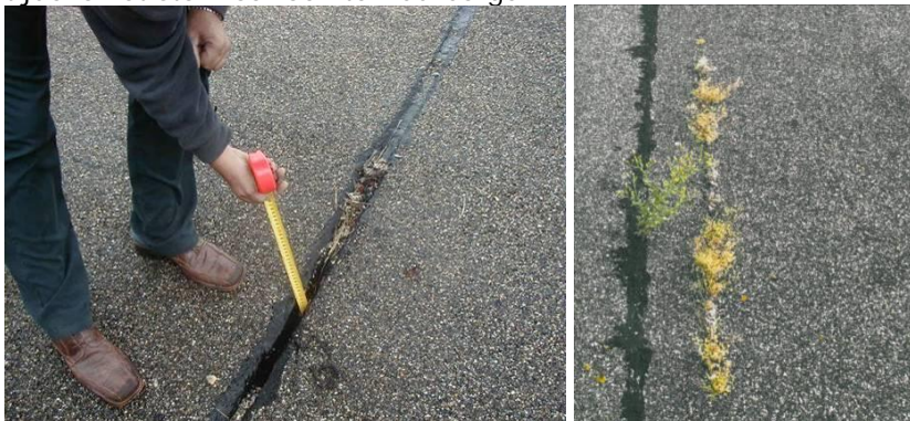
Figuur 9-2: Links: openstaande naad die al eerder was gevuld. Rechts: liplas met links in beeld een gevulde naad met een enkele plant en even rechts daarvan een strook vergeelde begroeiing in de scheur van de afgebroken lip (= situatie van Figuur 9-3 rechtsonder)
