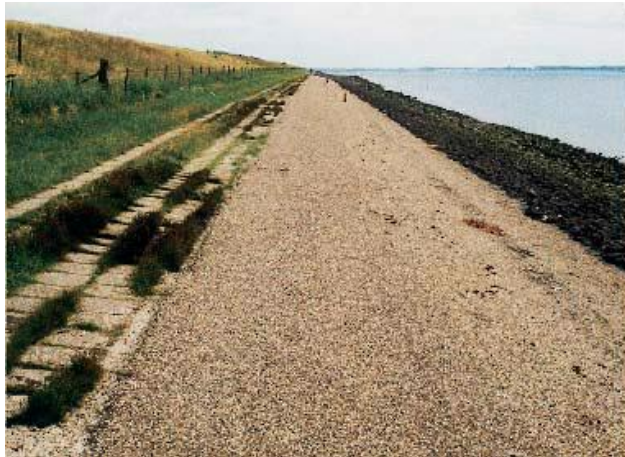
Figuur 13-1: Zeedijk met een bekleding van waterbouwasfaltbeton - Ouwerkerk – 1996 (foto Oranjewoud)
