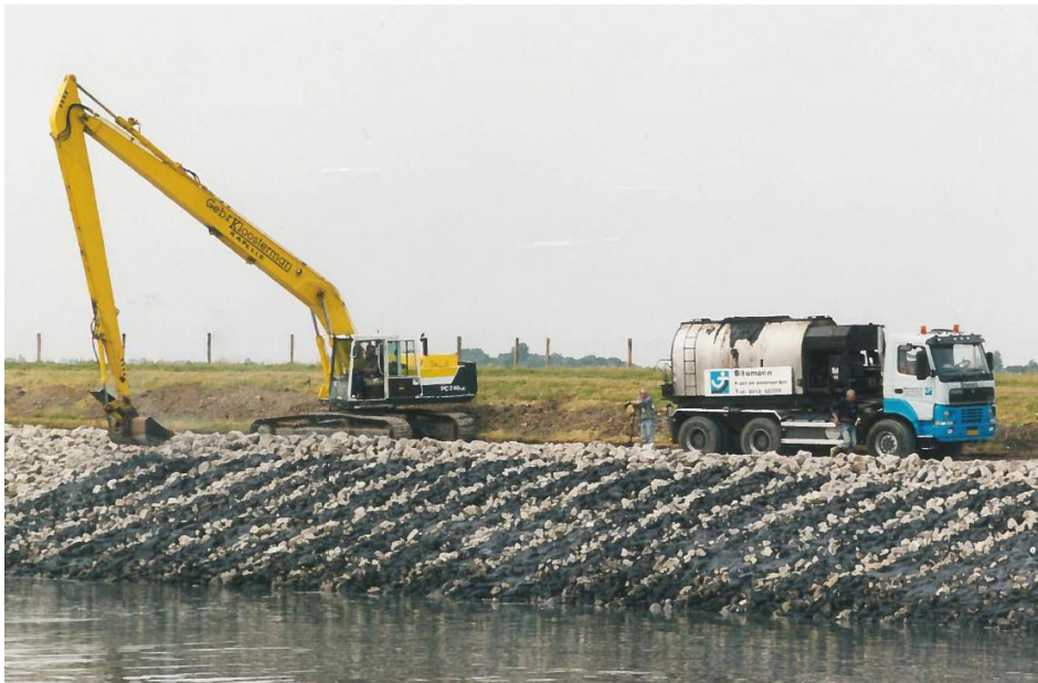
Figuur 4-21: Strokenpenetratie in uitvoering (foto Hydraphalt)
