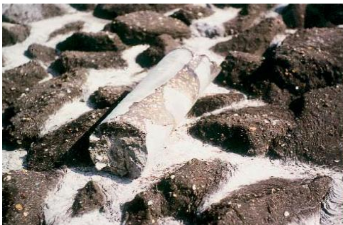
Figuur 11-14: Boorkern uit een bekleding van "vol en zat" gepenetreerde breuksteen - Westkapelse zeedijk - 1988
