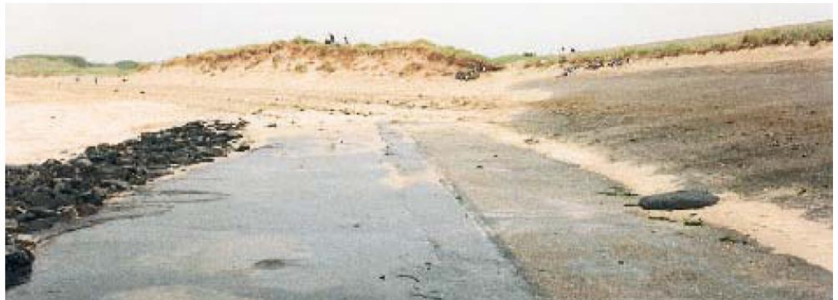
Figuur 13-2: Teenbescherming van gietasfalt - Veersedam - 1991 (foto Oranjewoud)
