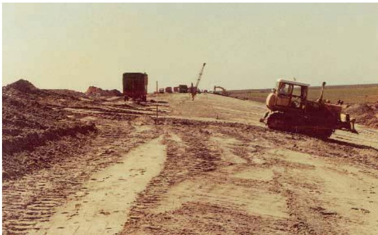
Figuur 8-1: Profileren van het zandbed - Sjoukeshoek – 1983
