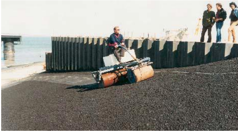
Figuur 8-13: Verdichten van waterbouwasfaltbeton - voorverdichting – Brugaanzet Neeltje Jans
