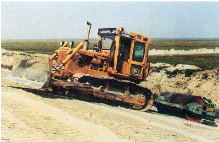
Figuur 8-2: Verdichten van het zandbed met een trillrol
