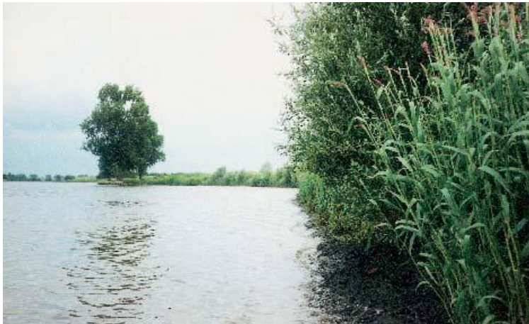
Figuur 3-15: Begroeide oever met open steenasfalt langs de Maas bij Bokhoven- 1995 (foto Oranjewoud)
