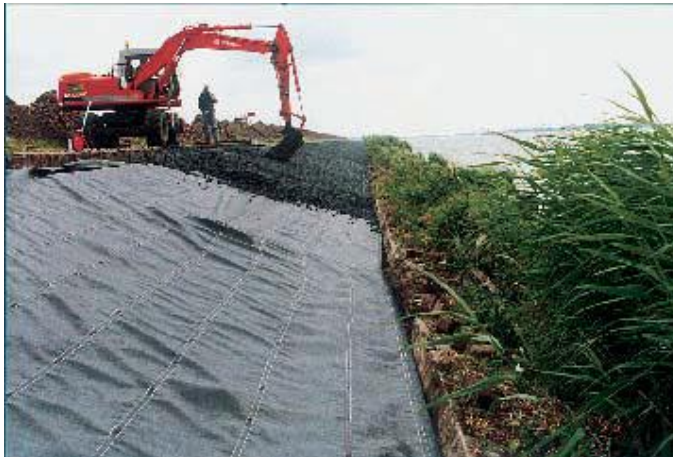
Figuur 8-21: Aanbrengen van open steenasfalt in situ - Eemmeer – 1993
