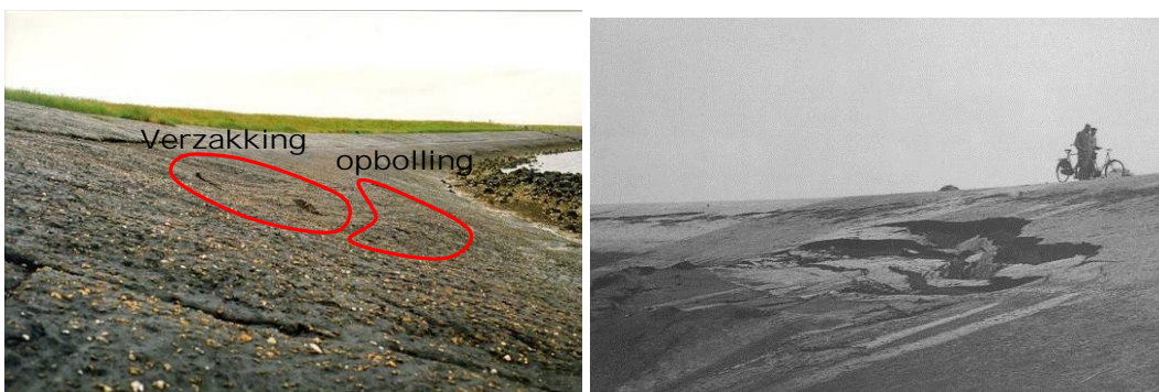
Figuur 9-10: Voorbeelden van instabiliteit van ondergrond
