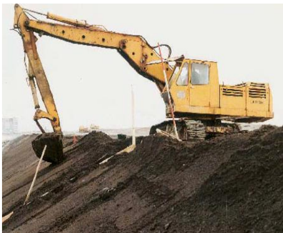
Figuur 8-26: Profileren van een zandasfaltdam - Zeebrugge in België (foto Bitumarin)
