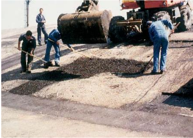
Figuur 10-13: Uitvullen van een gefreesde bekleding met waterbuwasfaltbeton – Roggeplaat – 1986
