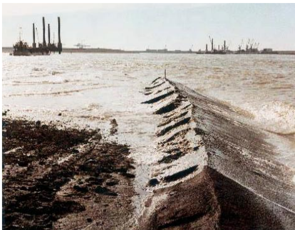
Figuur 8-27: Perskade van zandasfalt (foto Bitumarin)
