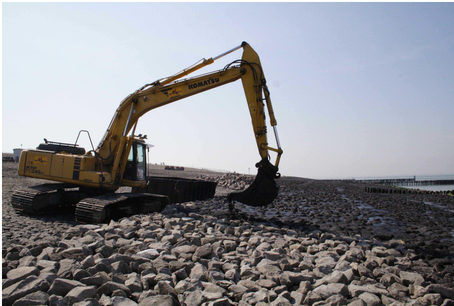
Figuur 8-19: Penetreren van een breuksteenoverlaging met gietasfalt met de bak van een hydraulische kraan – West-Kappelse zeedijk – 2006
