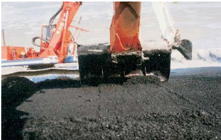
Figuur 8-9: Profileren van waterbouwasfaltbeton met een hydraulische kraan
