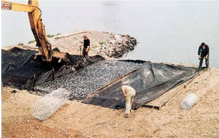
Figuur 4-50: Aanbrengen van wapening in een mat van open steenasfalt (foto Bitumarin)
