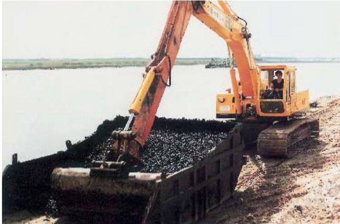
Figuur 8-8: Inrijbak als tussenopslag bij de verwerking van asfalt met een hydraulische kraan (foto Bitumarin)
