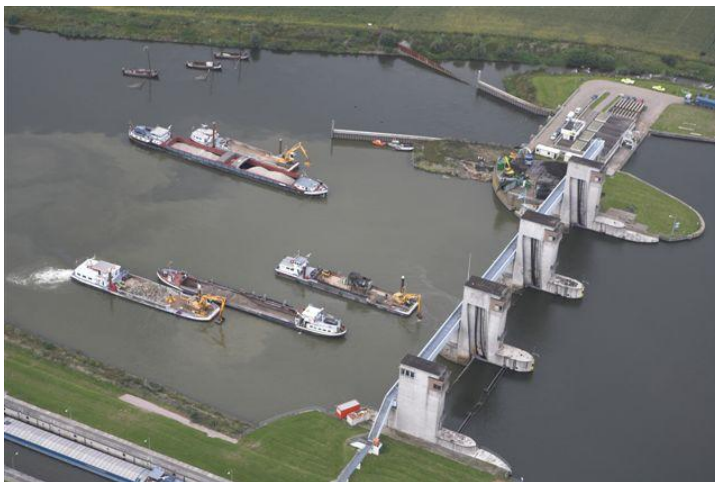
Figuur 4-16: Stippenpenetratie "dambord" onder water – Stuw Lith (foto Hydraphalt)
