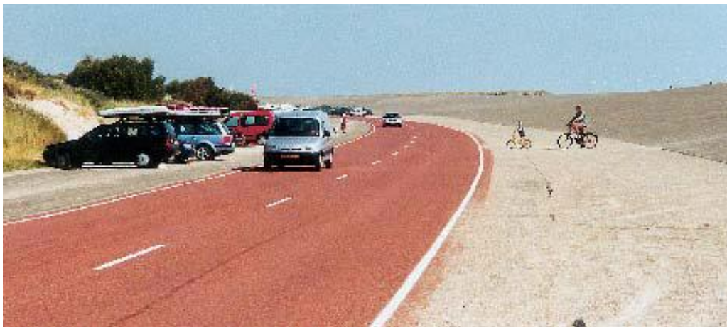
Figuur 3-13: Gekleurd asfalt op de Brouwersdam om de ligging van de rijweg te accentueren (foto NPC)
