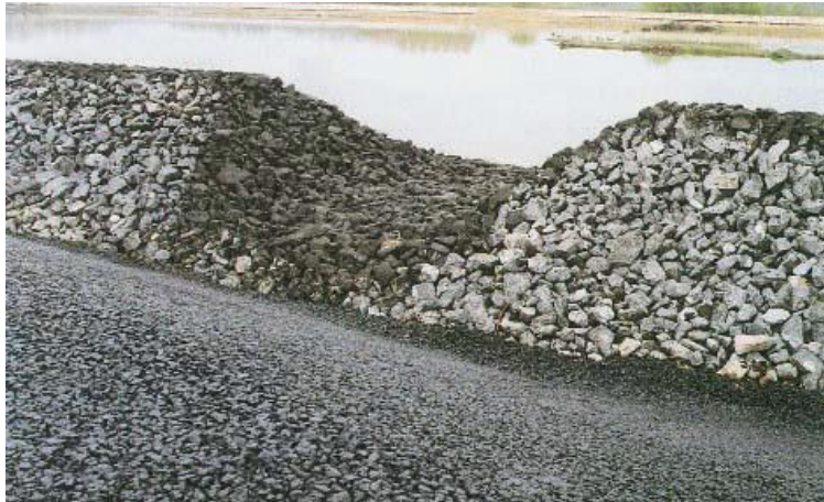
Figuur 13-4: Vooroeververdediging direct na aanleg - Zeekanaal Brussel-Schelde in België (foto Bitumarin)
