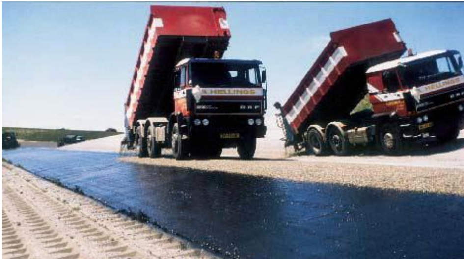
Figuur 8-30: Afstrooien met split voor het aanbrengen van een oppervlakbehandeling (foto ESHA)
