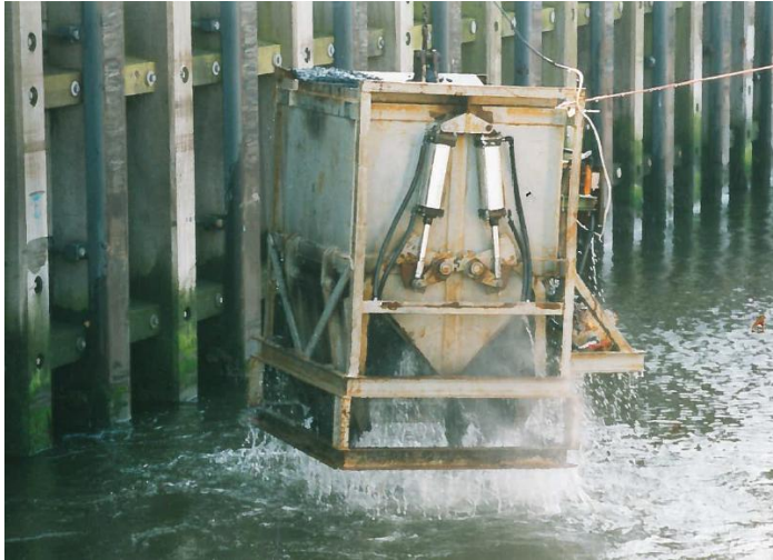
Figuur 8-9: Stortkoker voor de verwerking van asfalt onder water – Sluis Gorinchem (Foto Hydraphalt)
