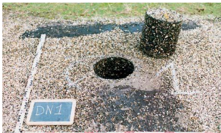
Figuur 11-12: Boorkern uit een bekleding van waterbouwasfaltbeton - Damaanzet Noordland - 1991 (foto NPC)
