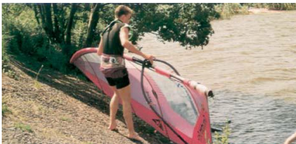
Figuur 3-12: Begaanbaarheid van een bekleding van open steenasfalt als oeverbescherming van een recreatieplaats (foto VBW-Asfalt)
