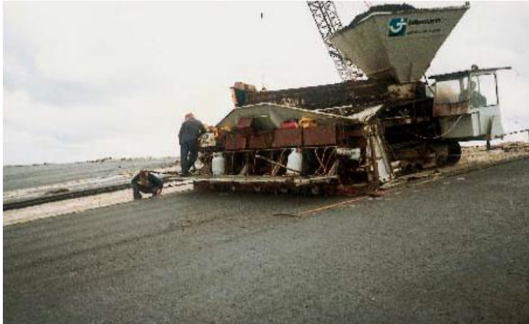
Figuur 8-12: Slipformpaver - Westkapelle – 1988
