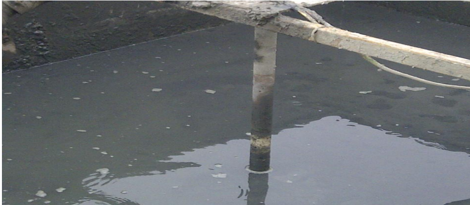
Figuur 2.4 Het in suspensie brengen van het slib door middel van staafmixer.
