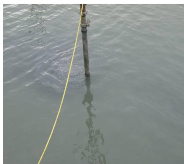
B: Aanleg Vak 2, Deelvak 2-1, in den natte. Kleine wolk zichtbaar
