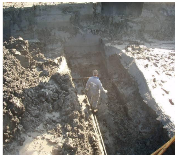
B: Inleggen van zettingsmeetslang en verankering van slang door middel van indrukken perkoenpalen.
