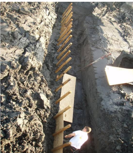
Figuur 3.3 Inzetten van afscheiding Vak 1 en Vak 2
