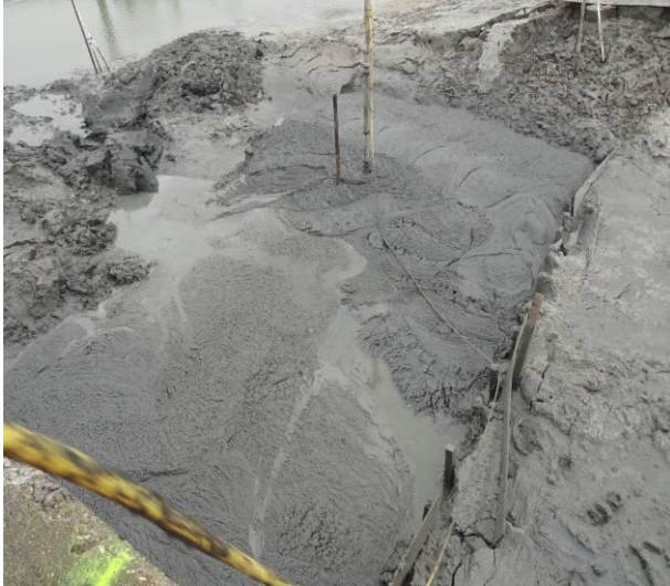
A: Afvloeiing van zeewater tijdens aanleg van laag 2 in Vak 1.
