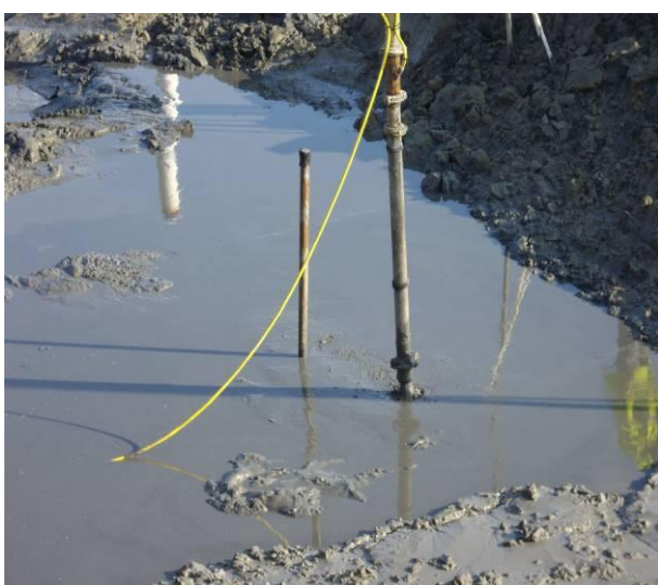
C: Aanleg van Vak 2, Deelvak 2-3.
