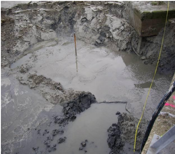
C: De dag na aanleg van Vak 3 (3-november)
