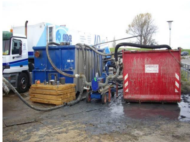
B: De twee mengbakken, de pomp en de mengwagen van Faber
