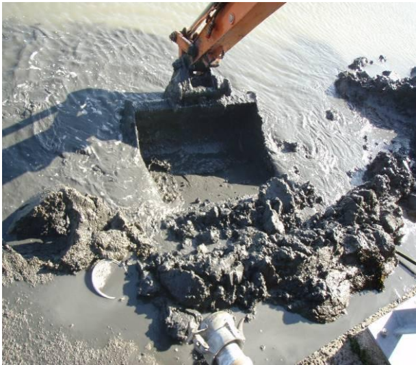
Figuur 2.2 Bewerking sediment in den natte
