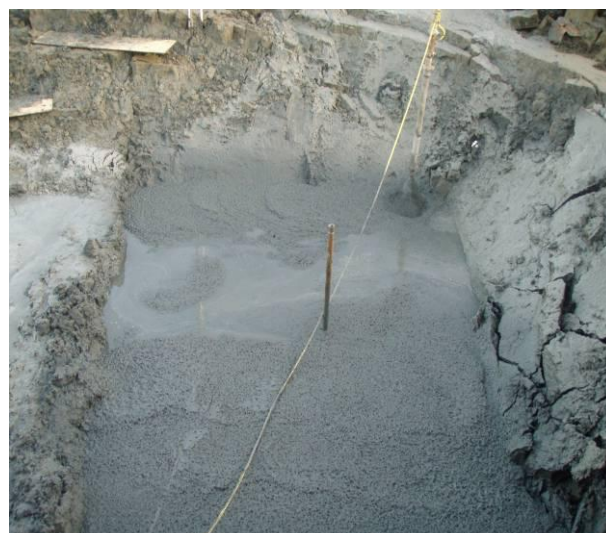
B: Aanbrengen van toplaag in Vak 3.
