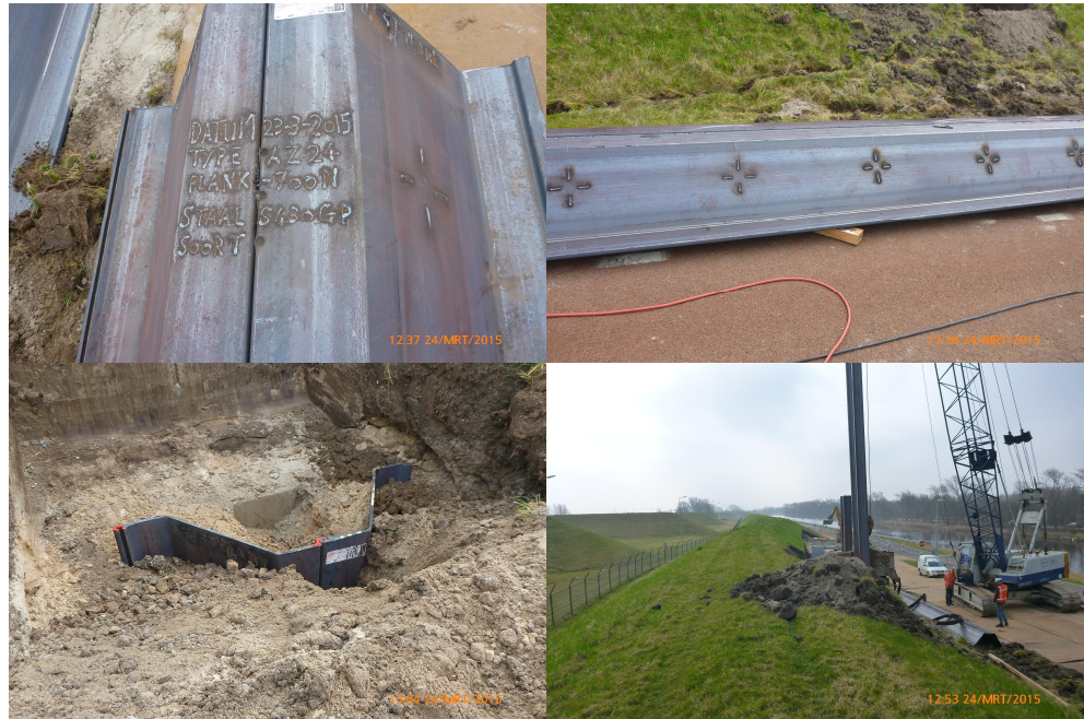
Afbeelding 4.2: Testplank Koegraszeedijk. Met de klok mee (vanaf linksboven): de geprepareerde testplank; de externe dradenkruizen die de plaatsen aangeven voor de ultrasonische diktemetingen; het slaan van de damwand in de Koegraszeedijk; de losse testplank na het aanbrengen.
