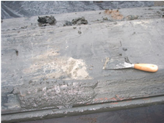
Afbeelding 1.3: plank Dordrecht: een dunne wit-grijze deklaag [GeoDelft 2007]
