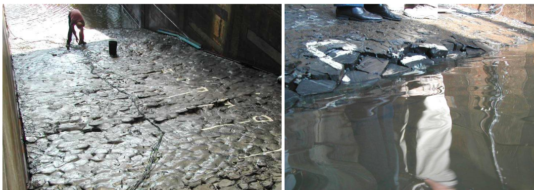
Figuur 2.21. Talud na P21. Links: overzicht. Rechts: Overgang ingegoten/niet-ingegoten.
