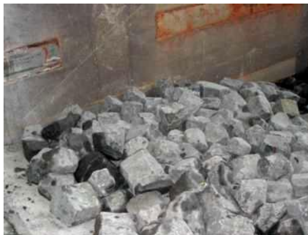
Figuur 3.3. Teenbestorting met basalt van 25 cm dik.
