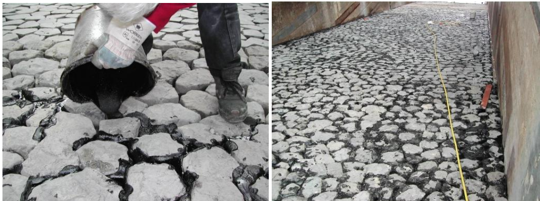
Figuur 2.5. De eerste ingegoten bekleding, gebruikt voor de proevenserie 1. Links: aanbrengen gietasfalt. Rechts: ingegoten bekleding zonder extra behandeling.
