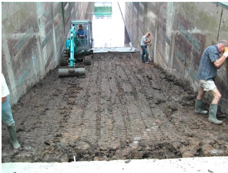
Figuur 3.2. Aanbrengen van de klei.
