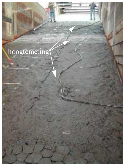
Figuur 3.8. Hoogtemeting en drukopnemers op talud.
