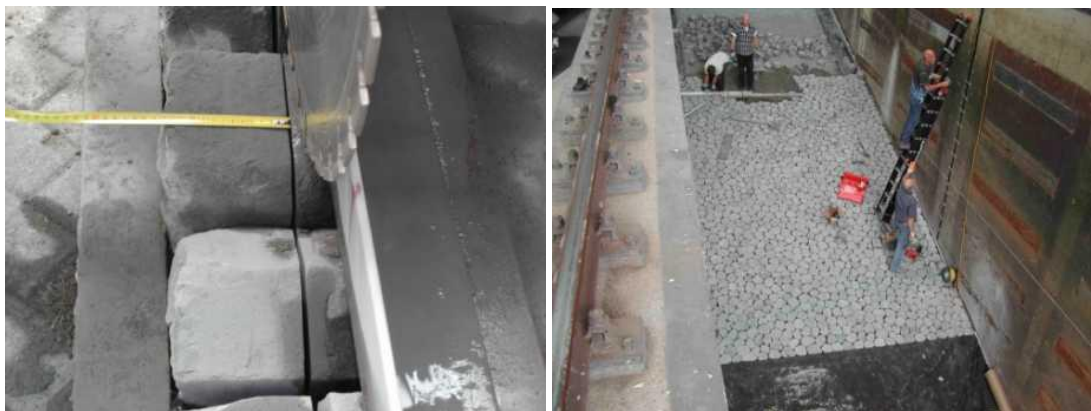
Figuur 2.4. Zagen (links) en zetten (rechts) van het basalt.
