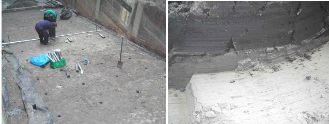
Figuur 3.12. Links: kleimonsters worden uit het talud genomen. Rechts: aansluiting van klei op zand.
