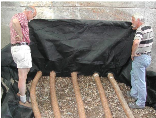
Figuur 3.4. Drainagebuizen voor zandinfiltratie.
