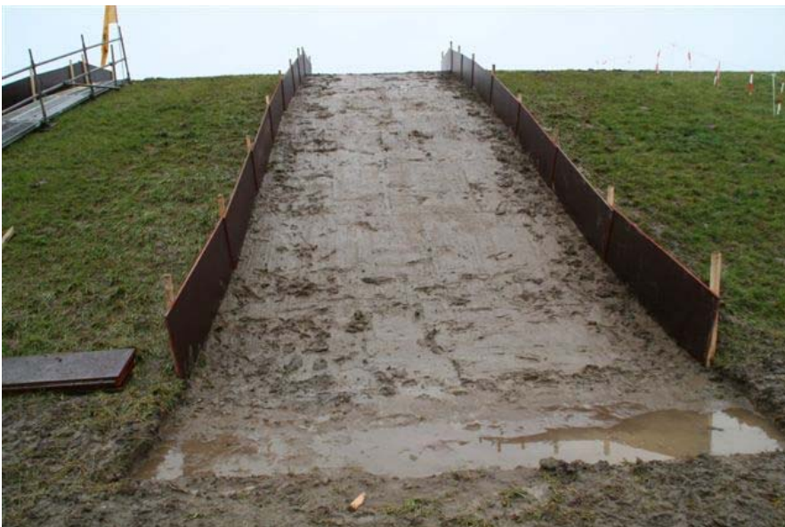
Figuur B29. Kattendijke, aanleg secties met elastocoast en open asfaltbeton. De grasmat werd ongeveer over 5 cm weg gehaald, een open geotextiel werd gelegd en daarop 10-15 cm bedekking met elastocoast of open asfaltbeton.
