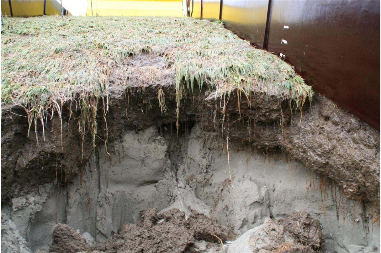
Foto F-7 Uiteindelijk bleek de op de zandkern aangebrachte kleilaag slechts 40 cm dik te zijn in plaats van de voorgeschreven 60 cm
