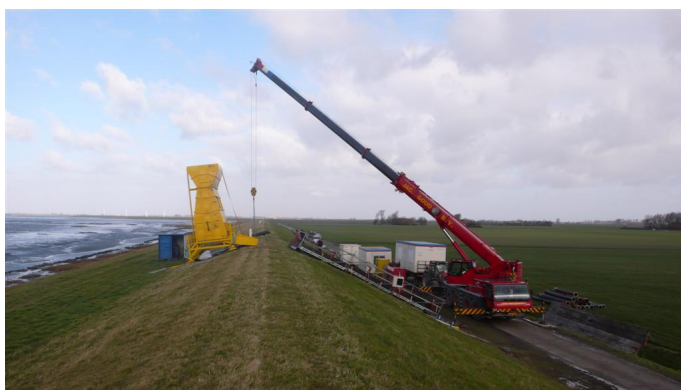
Figuur 2-9 Plaatsen simulator met behulp van een telescoopkraan (St. Philipsland)
