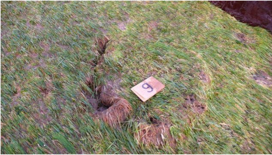
Figuur B25. Kattendijke; sectie 2, na 2 uur van 50 l/s per m. De paal op het talud werd eruit geslagen. Deze paal stond verticaal (dus niet loodrecht op het talud), 30 cm diep, en door de overslaande golf werd een moot klei met gras omhoog gedrukt en iets naar beneden.
