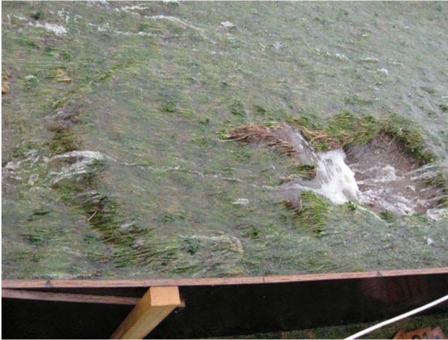
Figuur B5. Initiële schade Boonweg; sectie 3. Tweemaal hooien, geen kunstmest en in 17 jaar geen beweiding. Schade op de foto in het tweede uur van 75 l/s per m. Op dat moment voelde de grasmat “sponzig” aan. Mogelijk is door de losse bovenstructuur klei geërodeerd tussen de wortels. De kracht van het water op het gras met het bovenste deel van de wortels werd zo groot dat onder de zode de wortels zijn geknapt. Er ontstond een “ballon”, gevuld met water. Bij een van de volgende golven werd de ballon opengeslagen en verdween een deel van de grasmat.
