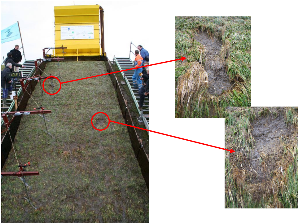
Figuur 7-3 Substantiële schade talud bij begin van de proef met 50 l/s per m. De details geven het schadebeeld aan het eind van eerste 2 uur weer.
