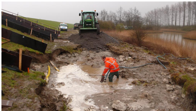
Figuur 8-6 Herstelwerkzaamheden schadebeeld
