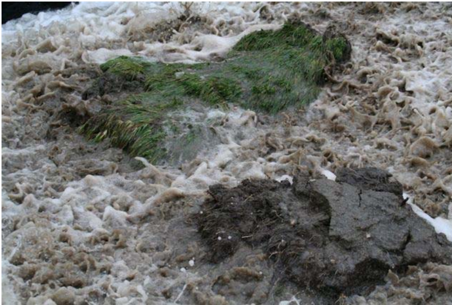
Figuur B10. Boonweg; sectie 4. Het openslaan van de tweede ballon enkele minuten nadat deze was ontstaan. Er zit nog een kleilaagje aan de wortels, wat bevestigt dat de wortels zijn geknapt op de diepte waar het aantal wortels duidelijk minder is dan daarboven. Het aanwezig zijn van de kleilaag geeft de reden waarom de "ballon" zo waterdicht is, want de grasmat zelf is natuurlijk niet waterdicht.
