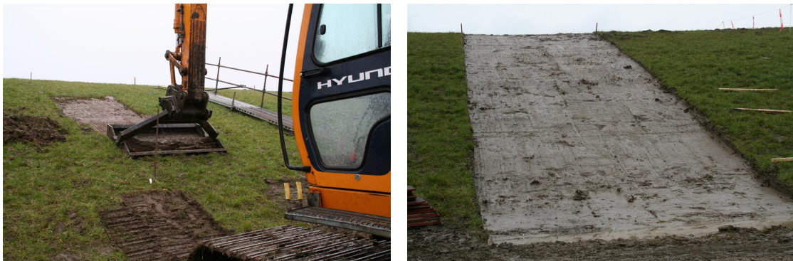
Figuur 2-5 Het verwijderen van de graszoden
