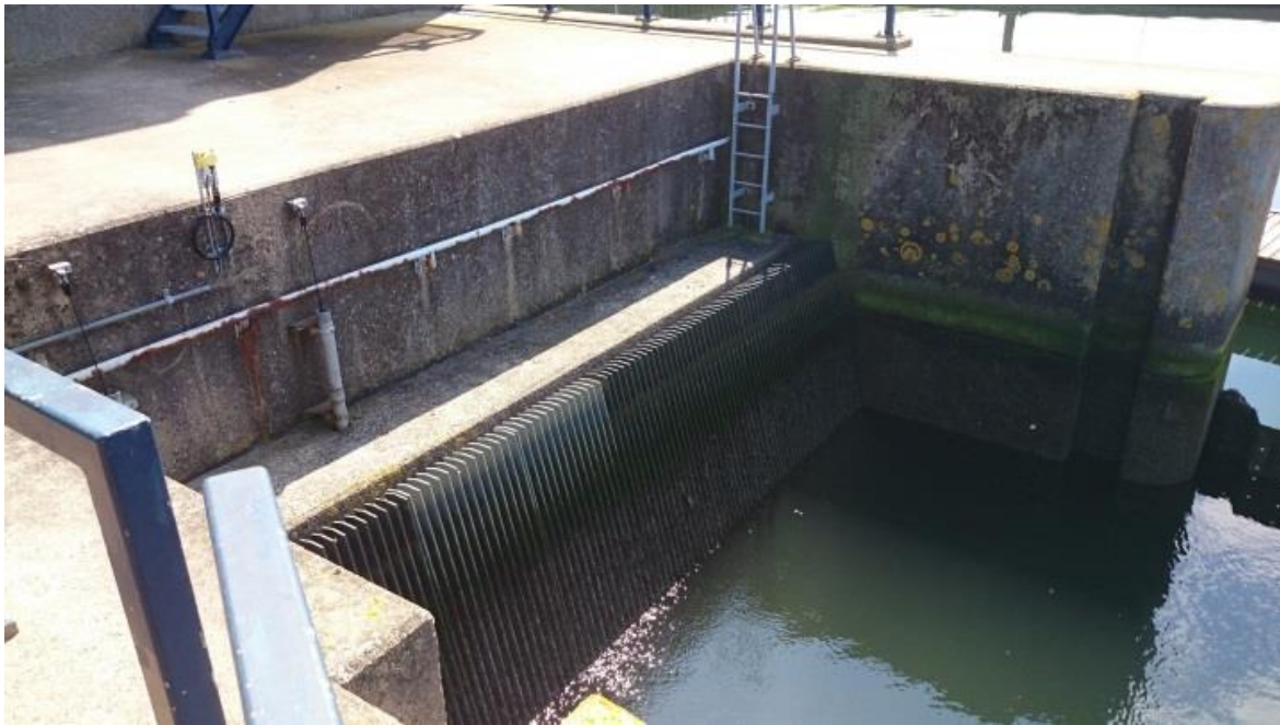
Foto 4. Rooster aan de Oosterscheldekant bij Kramerjachtensluis
