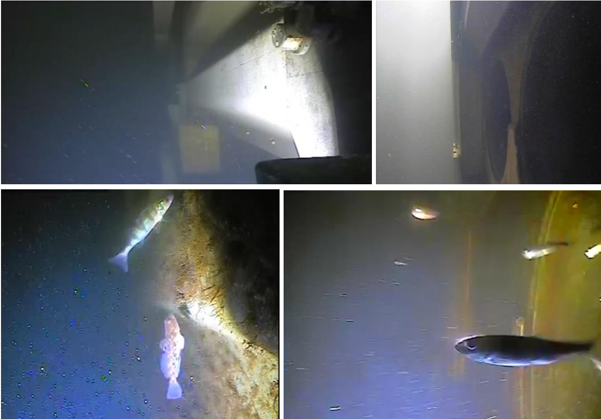
Foto 5, 6, 7 en 8. Krammerjachtensluis met dichte en open schuiven, met baars, grondel en sprot.
