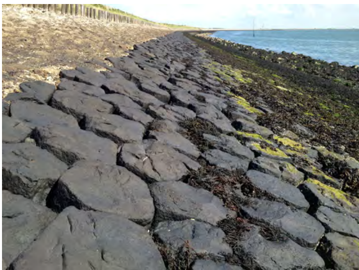
Dijkvak 2. In groepen voorkomend Groefwier vanaf dijkpaal 37,9.
