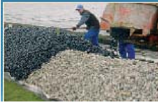
Aanleg overslagdijkje met Elstogran.
