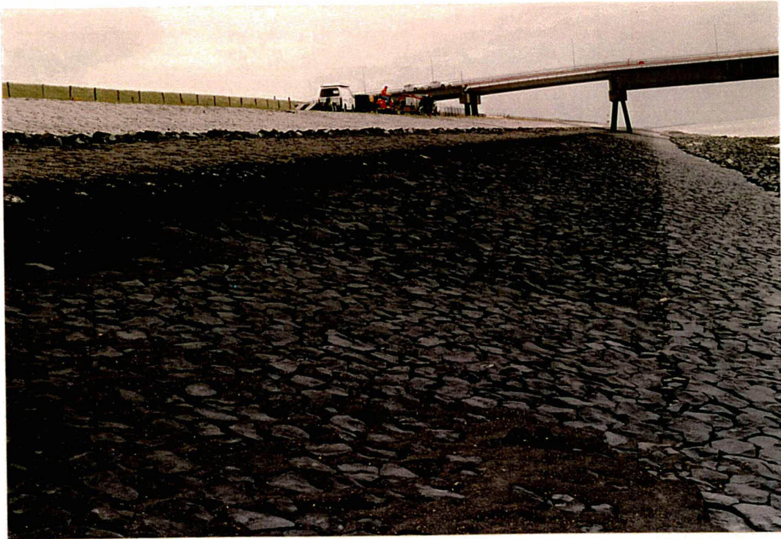
Foto 5 Overgang in hoogte van het gepenetreerde gedeelte bij dp 38 + 30 m. Een gedeelte van het basalt is op een vlak filter gezet.
