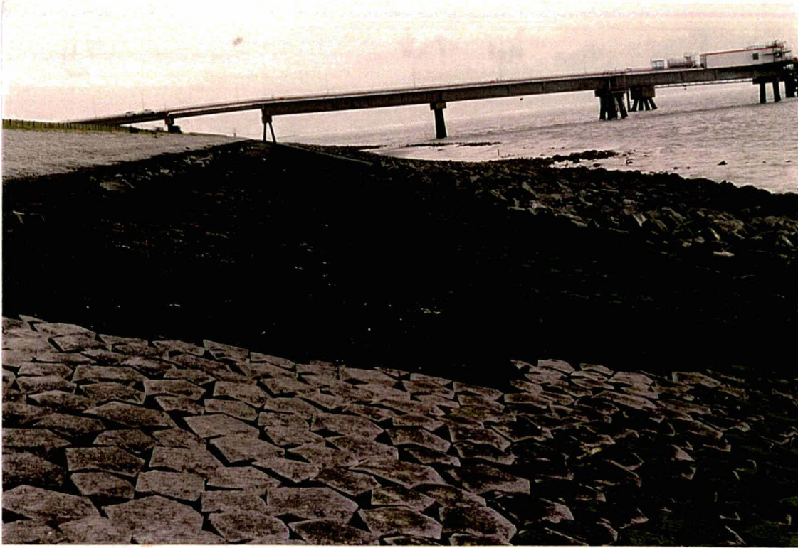
Foto 1 Overzicht van het begin van het vak bij dp 39, foto genomen in oostelijke richting. Op de teen van het talud is overlaging aanwezig.
