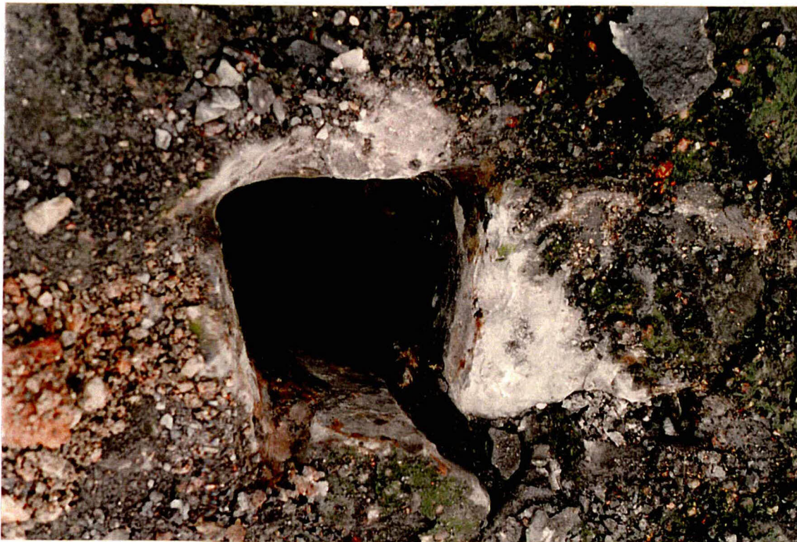
Foto 16 Gat in talud bij cp 32. De laagdikte is hier groter, de penetratie goed.
