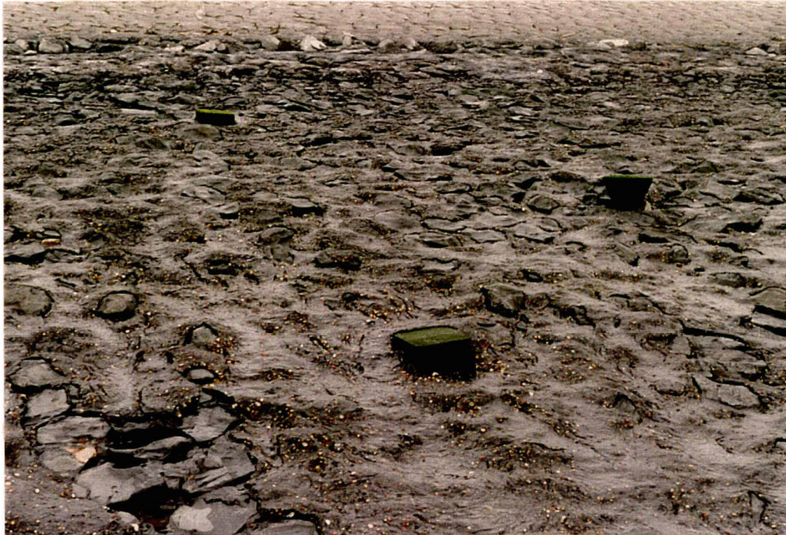
Foto 11 Bij dp 34 + 50 m staan drie houten palen in het talud.
