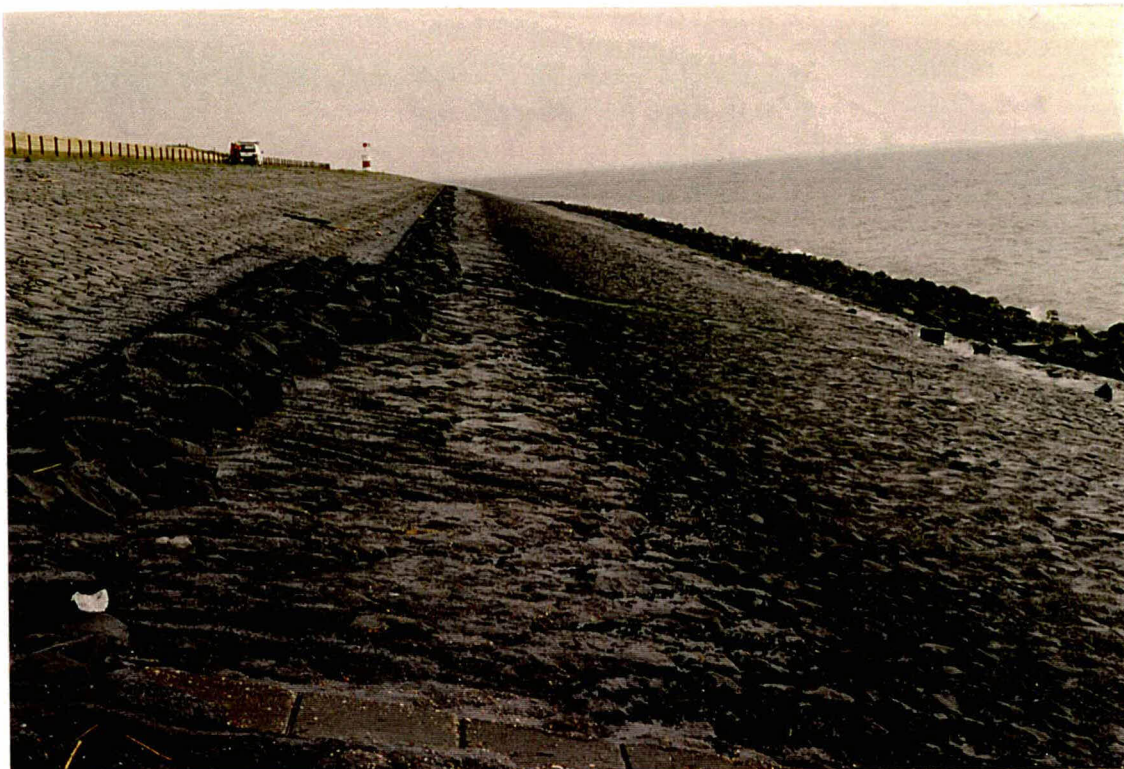
Foto 9 Bij dp 35+30 m is het gepenetreerde basalt weer over grotere hoogte aanwezig. De bovenkant van het basalt verspringt.
