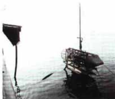
Foto 4 Watermonsters worden genomen met behulp van een meetvis.
