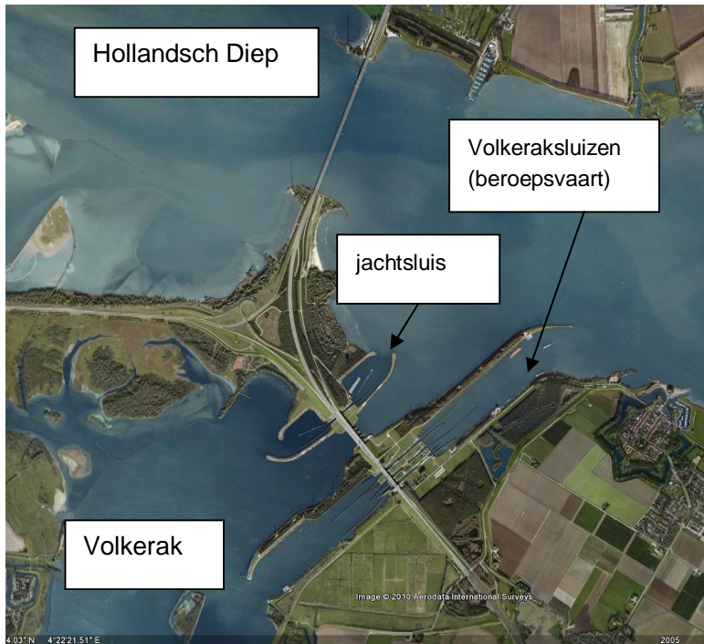
Figuur 1.1 De Volkeraksluizen vormen de verbinding tussen het Volkerak en het Hollandsch Diep. De scheepvaartsluizen bestaan uit 3 beroepsvaartsluizen en 1 jachtensluis. (Bron: Google Earth)
