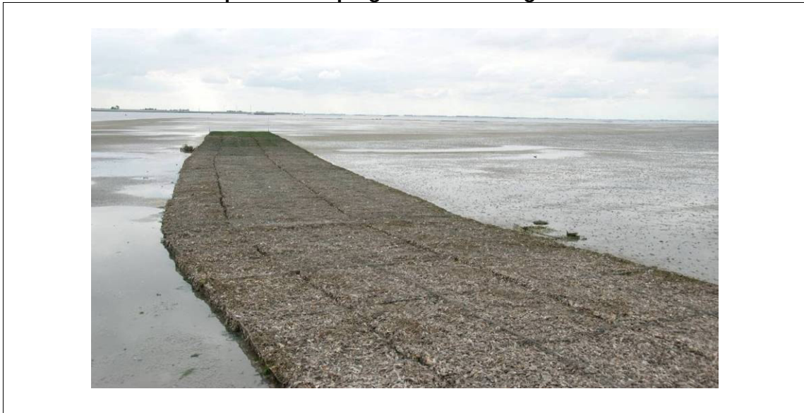
Afbeelding 4.9. Experimentele aanleg oesterrif bij De Val, aangelegd door Stichting Ecoshape voor het programma 'Building with Nature'
